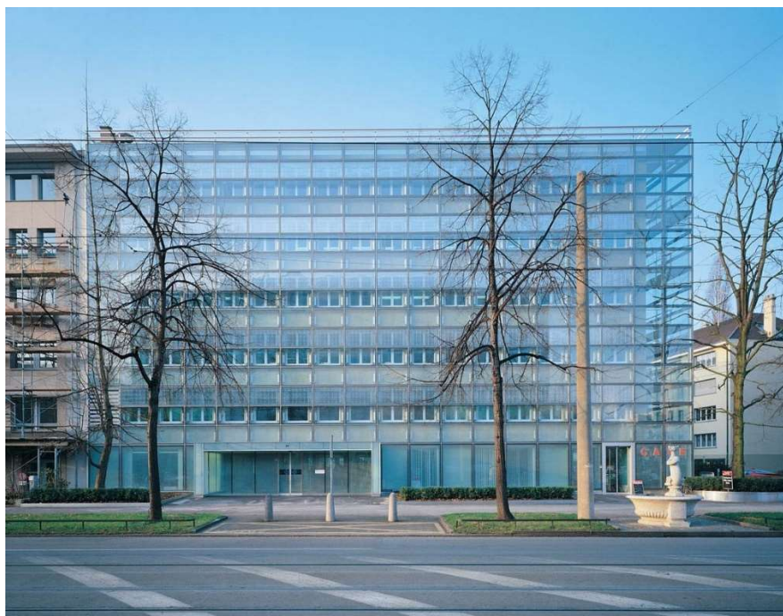
Figura 4 Fachada do edifício SUVA de Herzog e De Meuron Fonte: Walti (n.d.)
