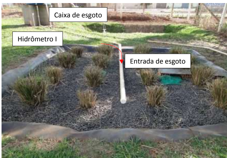
Figura 4.7 – Imagem da WC-FSSV. Destaque para a tubulação superficial de distribuição do esgoto primariamente tratado.
