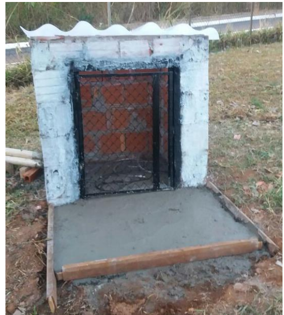
Figura 4.15 – Estrutura montada para alocação do amostrador automático.
