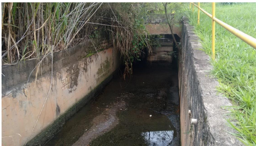
Figura 4.19 – Local de realização das medições de vazão.
