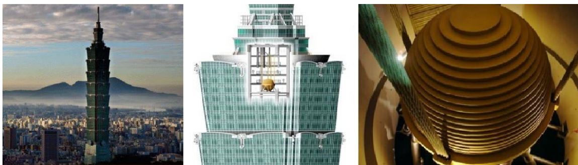
Figura 2.15 – Taipei 101 (a) e AMS pendular instalado na estrutura (b) e (c). (Fonte: Oliveira, 2012).
