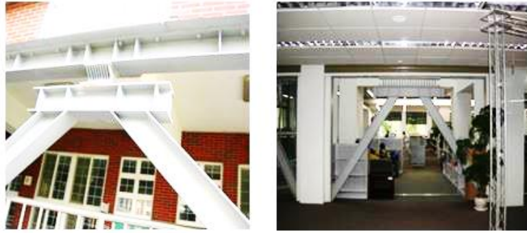
Figura 2.9 – Amortecedores Metálicos (Fonte: Teruna et Al., 2014).
