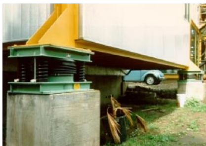
Figura 2.11 – Amortecedor Viscofluido em base de edifício (Fonte: Soong & Dargush, 1997).
