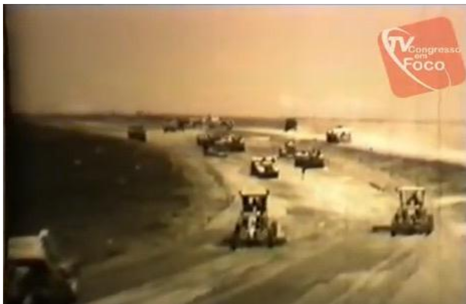
Figura 1: tratores realizando serviço de terraplanagem na região.
