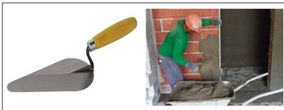
Figura 2 - (a) Colher de pedreiro usada na execução; e (b) Processo convencional de aplicação
