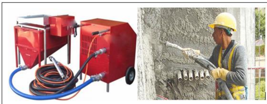
Figura 1- (a) Bomba de projeção de argamassa; e (b) Projeção da argamassa usando bombas
