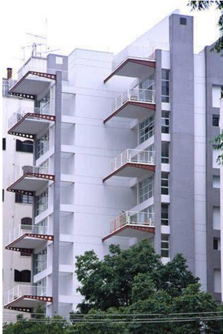
Figura 29: Edifício Mada Loft, de Rocco Vidal. Fonte: LIMA, 2013. p.143
