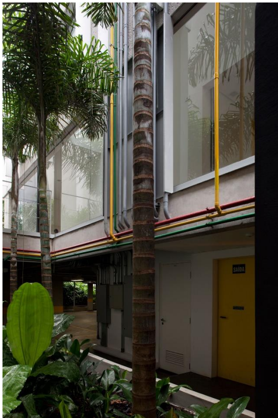
Figura 42: Instalações externas do ed. Aimberê 1749. Versatilidade na escolha do posicionamento de áreas molhadas no apartamento. Fonte: ideazarvos.com.br
