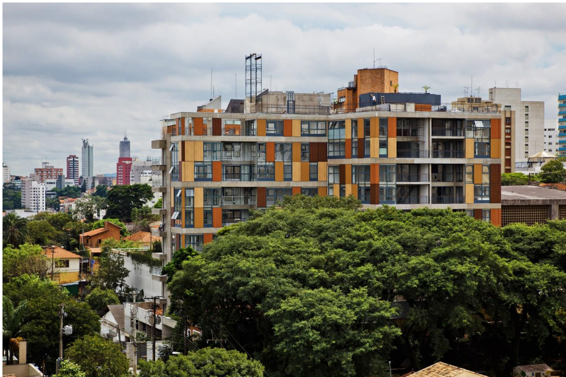
Figura 20: Edifício Fidalga 772, de Andrade Morettin. Destaque para a fachada composta de painéis de madeira em tonalidades distintas criando ritmo em oposição às transparências dos painéis de vidro. Autor: Nelson Kon. Disponível em < https://www.archdaily.com >, acesso em 30/3/2018.
