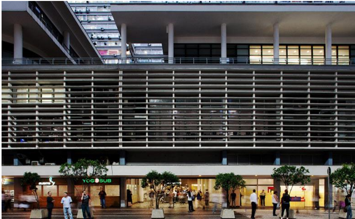
Figura 19: Fachada posterior do edifício Conjunto Nacional, de David Libeskind (1955). As galerias internas fazem a integração da Av. Paulista com as demais ruas que conformam o quarteirão. Fonte: Revista KAZA. Disponível em < http://www.tecto.com.br/RevistaKaza/News/2014/04/10/O-adeus-a-David-Libeskind-autor-do-Conjunto-Nacional >, acesso em 30/3/2018.
