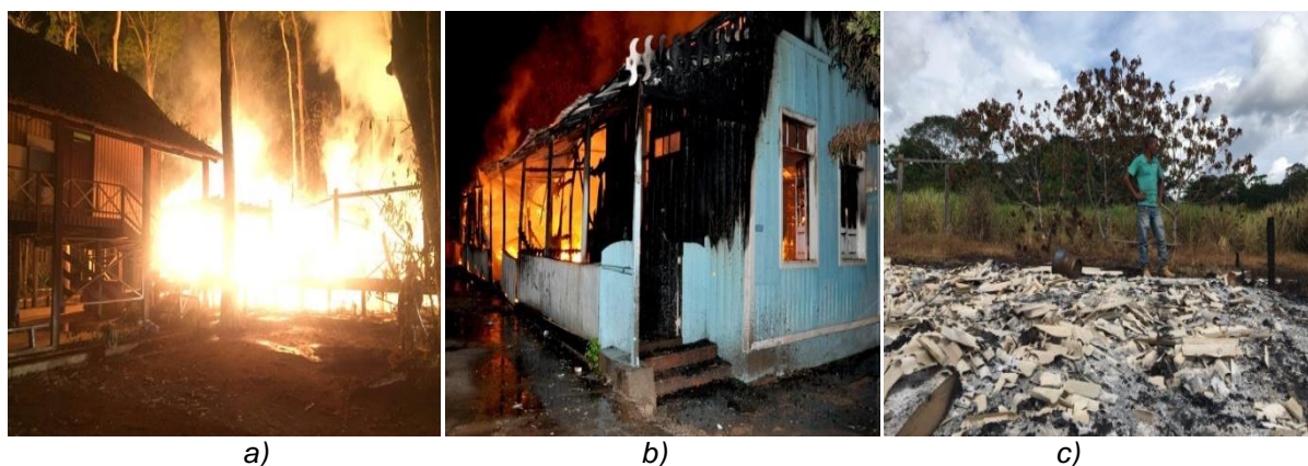
Figura 17 - Incêndios no Acre: a) Incêndio no Departamento de Patrimônio Histórico do Acre em 2016; b) Incêndio da casa da escritora Florentina Esteves em 2013, uma das casas mais antigas de Rio Branco; e c) Incêndio da casa de posseiro e militante em Xapuri, ocorrido em 2017. 36
