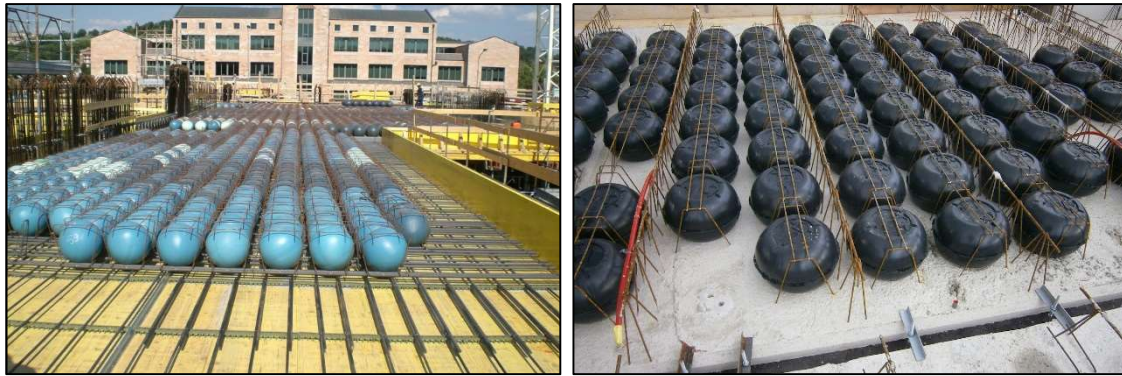
a) Concretagem em duas fases (página web Cobiax 6 )
