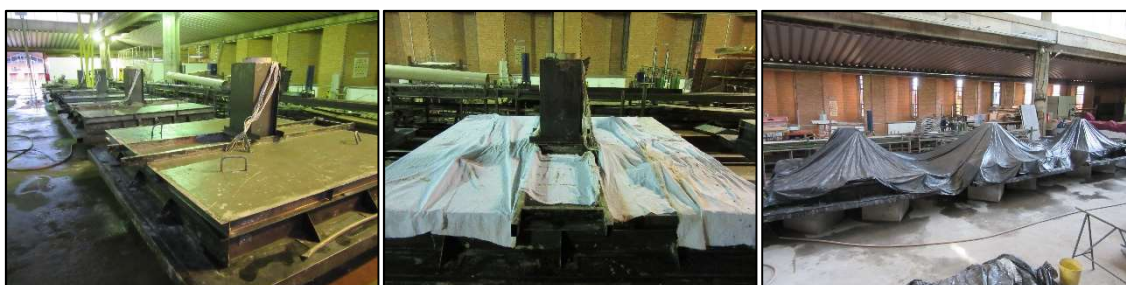
g) Lajes Concretadas h) Cura com mantas úmidas i) Cobertura após molhagem
