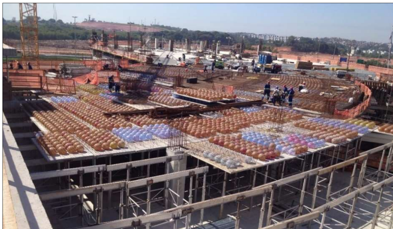
Figura 2.1 – Laje com vazios 1 (Sistema BubbleDeck )
