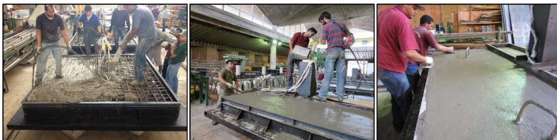
d) Concretagem final e) Concretagem do tramo superior do pilar f) Acabamento da laje
