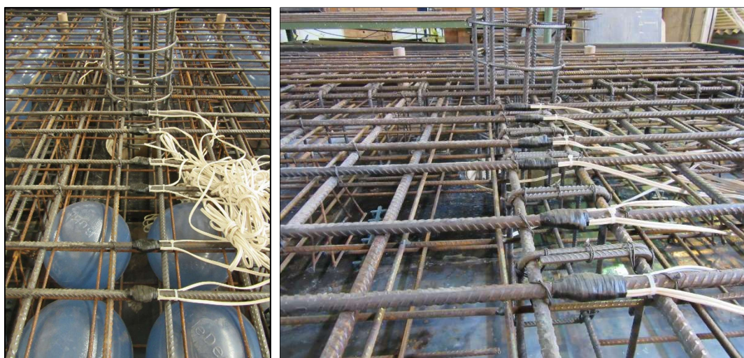
Figura 3.35 – Barras instrumentadas
