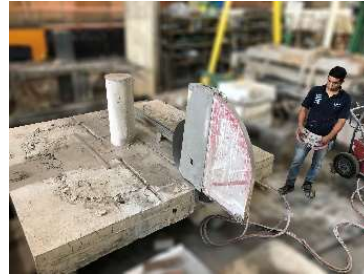
b) Execução do serviço de corte
