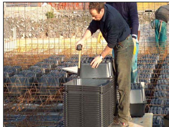
d) Armazenamento dos moldes
