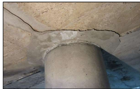
b) Acabamento da face inferior da laje SS2
