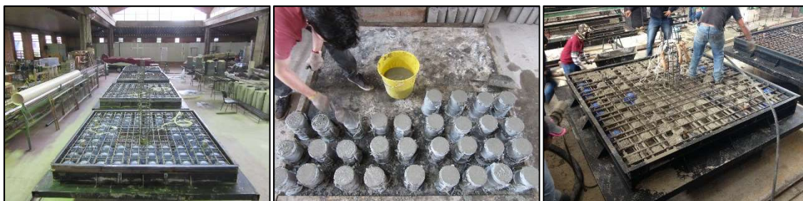
a) Lajes prontas para concretagem b) Moldagem dos corpos de prova c) Lançamento da primeira camada de concreto
