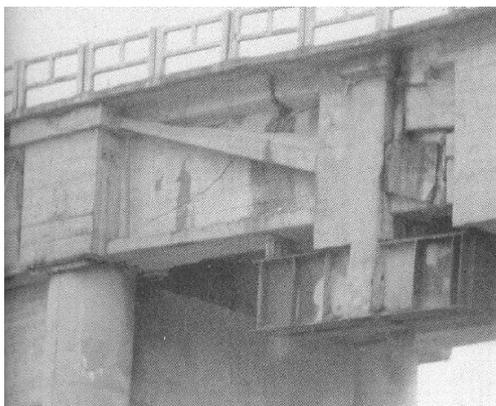
**Figura 1. 5 - Região colapsada da ponte no Rio Grande do Sul (Cunha *et al.*, 1998).**
