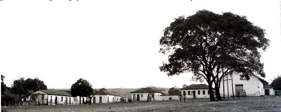
Figura 9 - Olhos d’Água: a Igreja de Santo Antônio de Pádua e ao fundo as primeiras casas.
