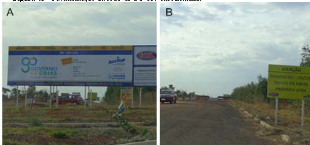
Figura 43 - Pavimentação da rodovia GO-139 em Alexânia.
