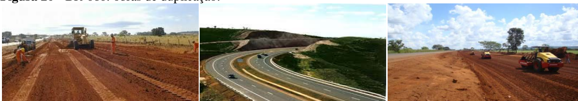
Figura 20 - BR-060: obras de duplicação.
