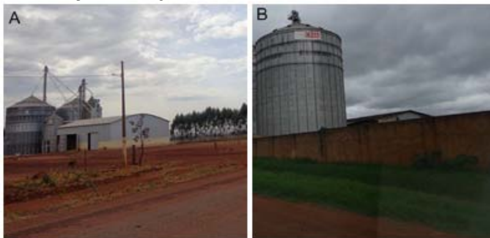
Figura 41 - Silos para Armazenagem de Grãos em Alexânia.
