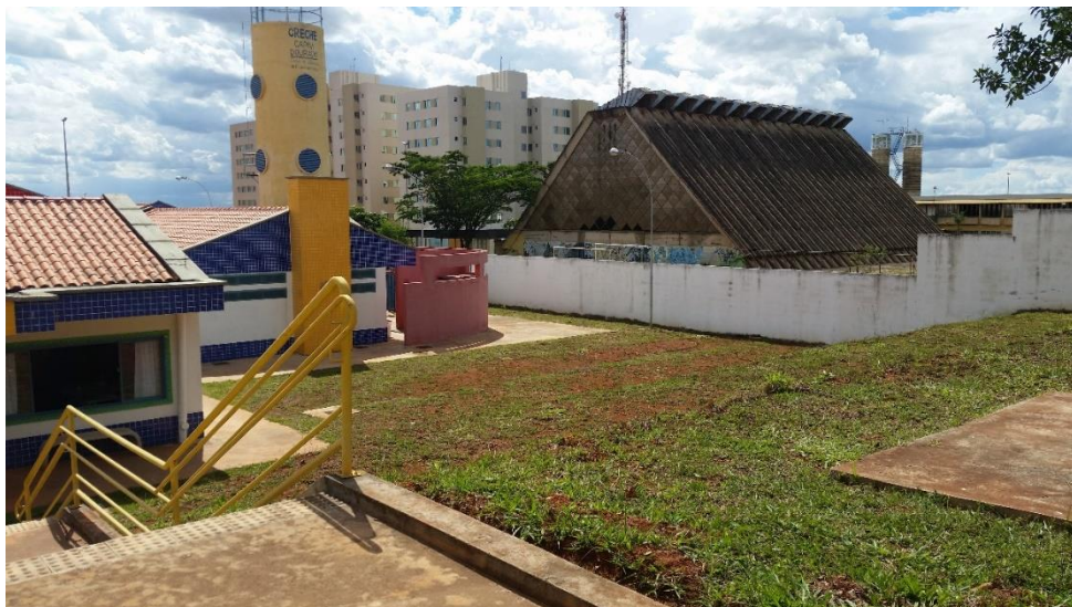
Figura 133: Declividade do lote inadequada à implantação do estacionamento – CEPI Capim Dourado.
