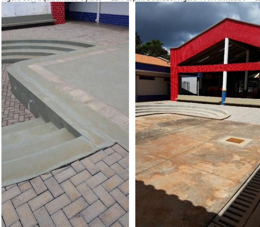
Figura 99: Arquibancada e palco – CEPI Capim Dourado. Figura 100: Anfiteatro – CEPI Jacarandá.
