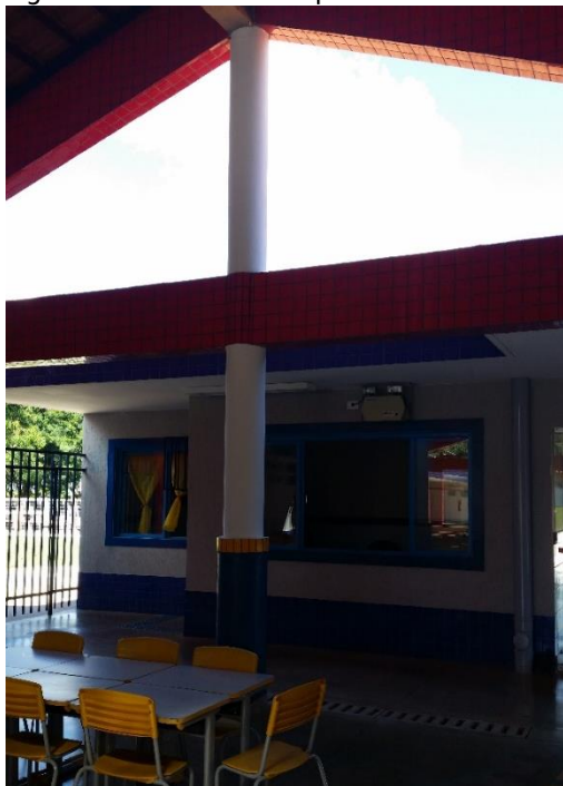
Figura 97: Vão aberto do pátio e refeitório – CEPI Jacarandá.
