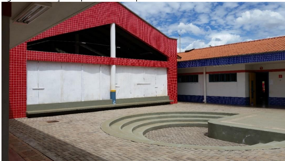
Figura 142: Vedação do pórtico – CEPI Capim Dourado.
