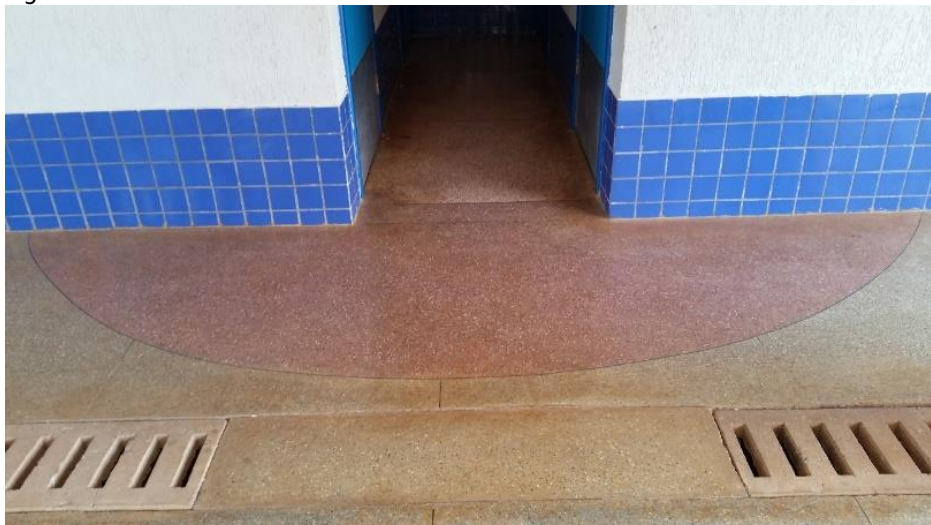
Figura 178: Corredor de entrada dos sanitários infantis - CEPI Jacarandá.
