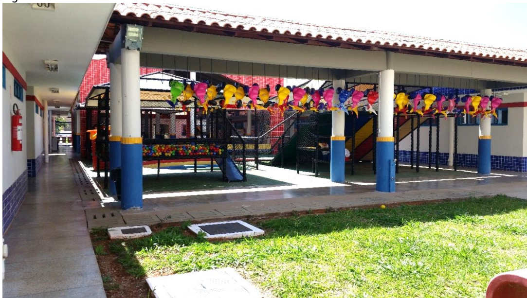
Figura 66: Passarela – CEPI Jasmim.
