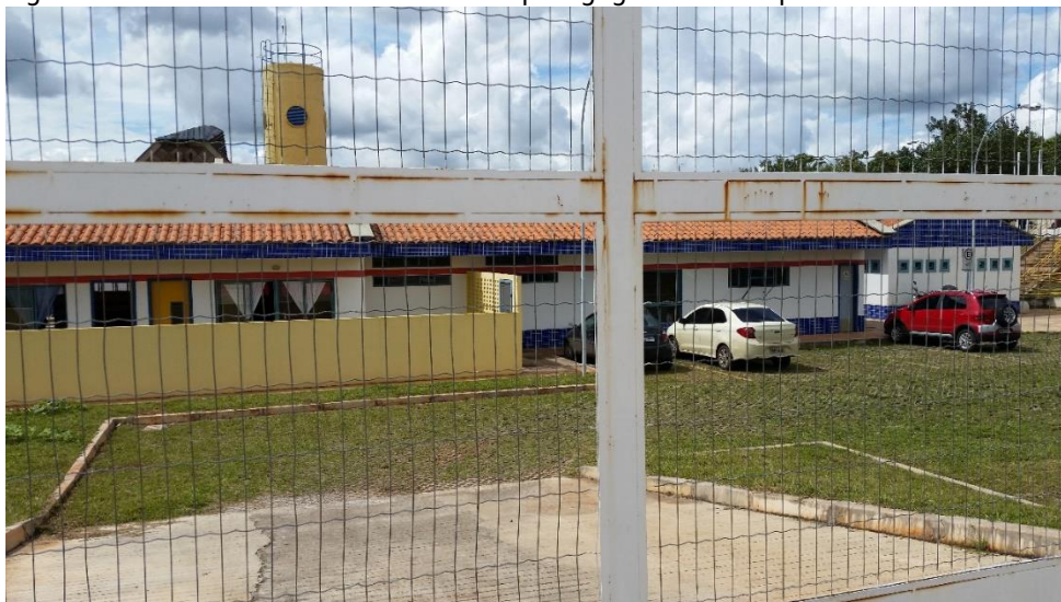
Figura 134: Estacionamento atrás do bloco pedagógico – CEPI Capim Dourado.
