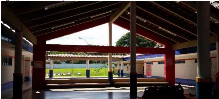
Figura 179: Pórtico do pátio coberto – CEPI Jacarandá.
