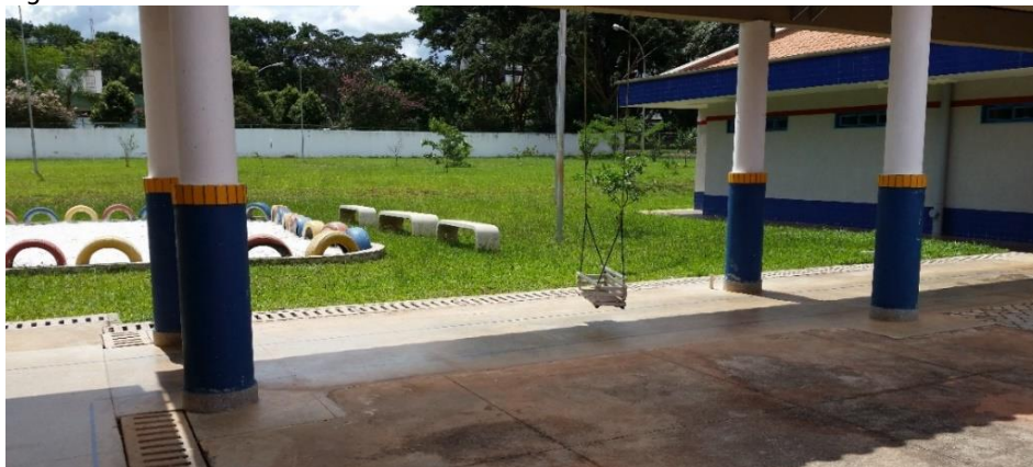
Figura 104: Passarela – CEPI Sabiá Jacarandá.
