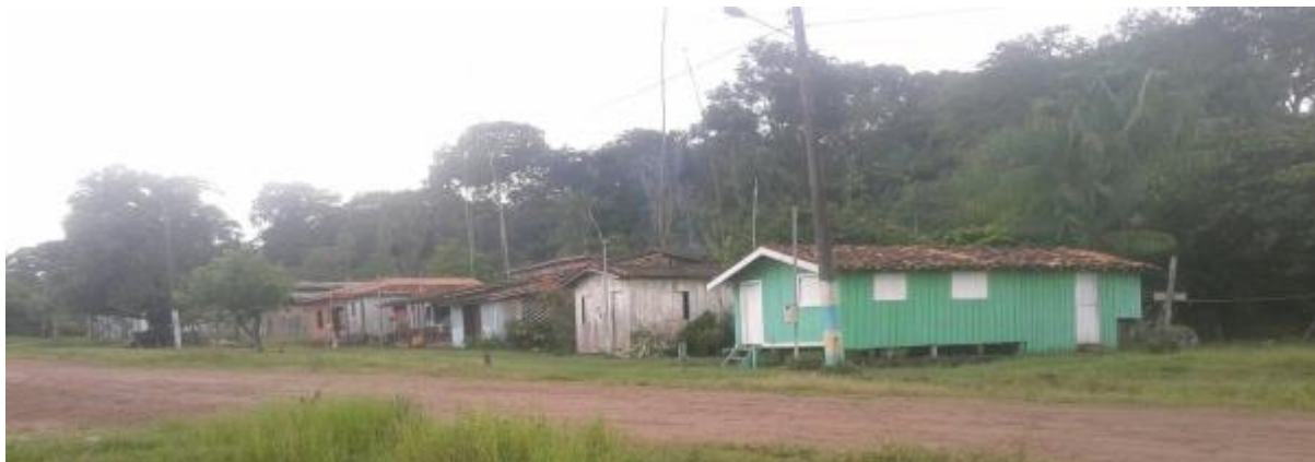
Figura 9 - Casas de moradores de Laranjituba
