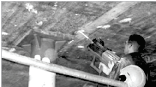
A Instalação do reforço
