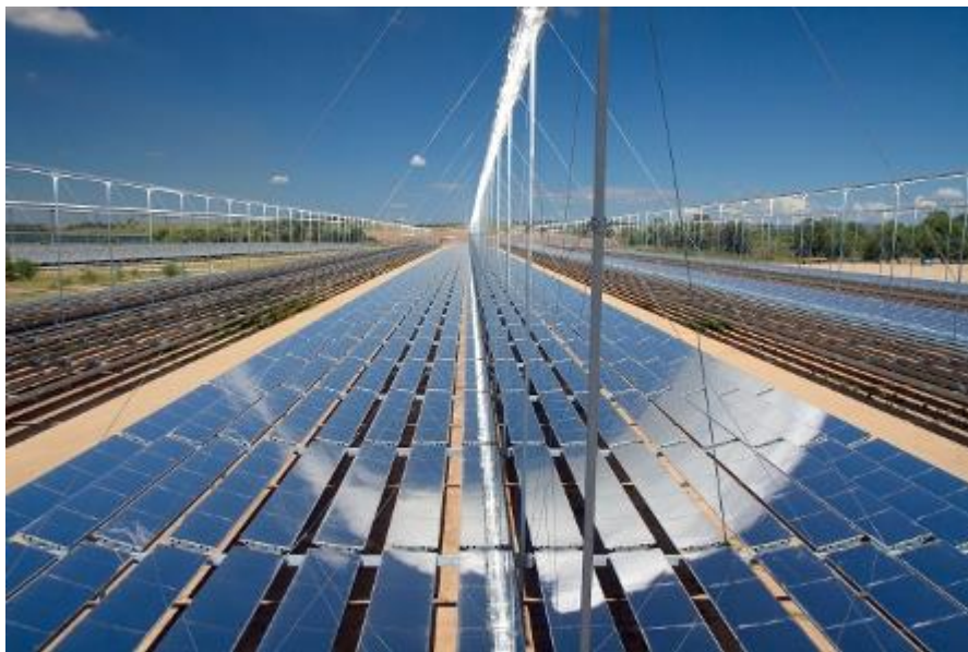
Figura 17 - Refletor linear Fresnel Fonte: (Togawa, 2015)
