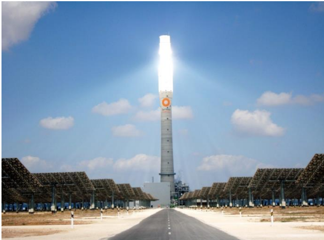
Figura 16 - Planta solar de torre central Fonte: (S. Craig, 2013)
