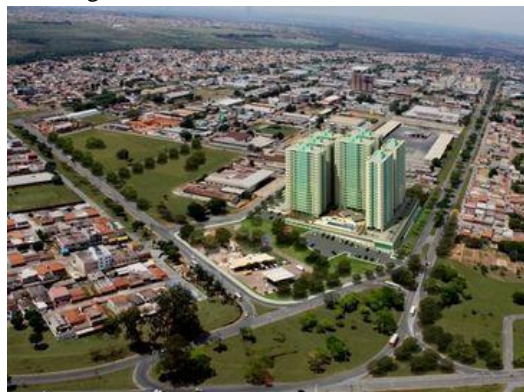
Figura 23 - Vista aérea atual do Gama.
