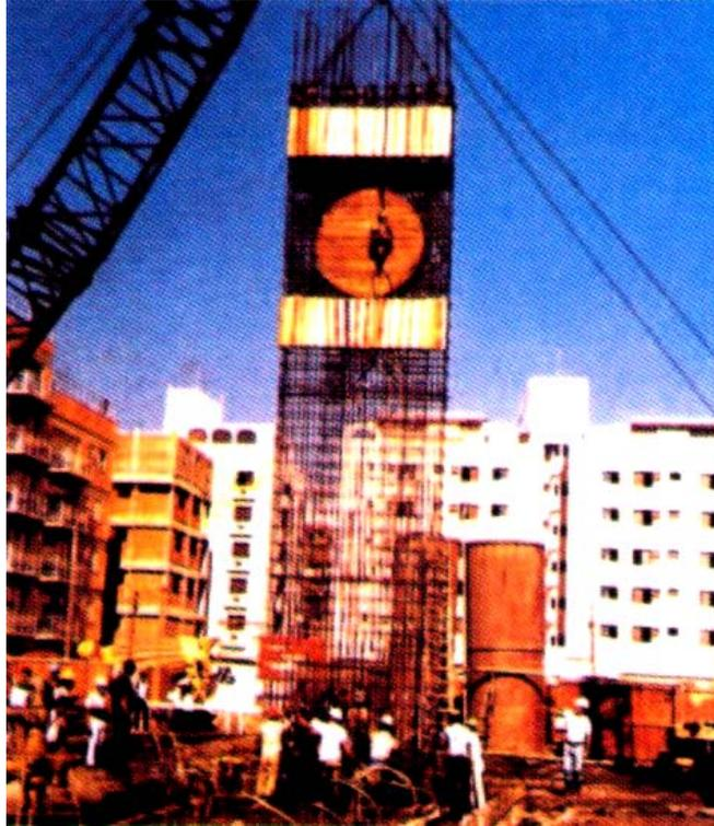
Figura 4.19 – Parede diafragma com nicho para tubulação (Fundesp, 2001).
