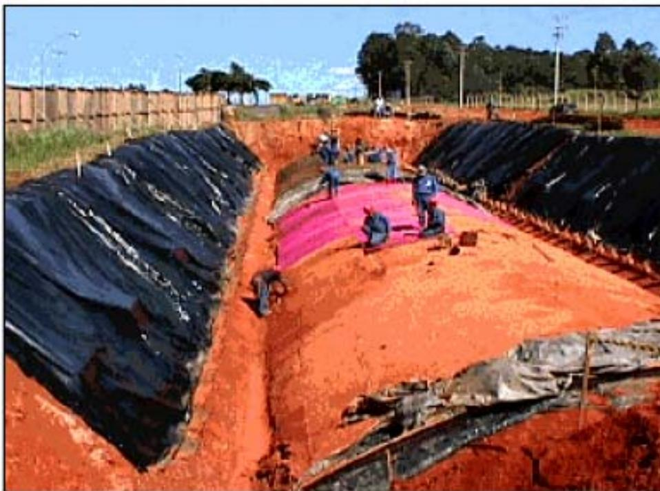
Figura 4.33 – Conformação da laje de teto do túnel (Hueb, 1998).
