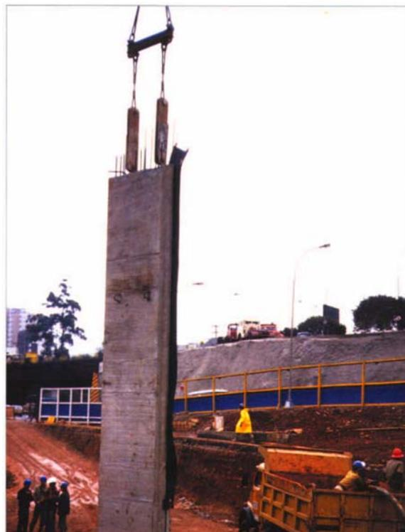
Figura 4.21 – Colocação da placa pré-moldada (Brasfond, 2007b).
