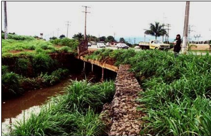
Figura 7.18 – Bueiro celular de concreto armado no córrego Capim Puba, à montante da via.
