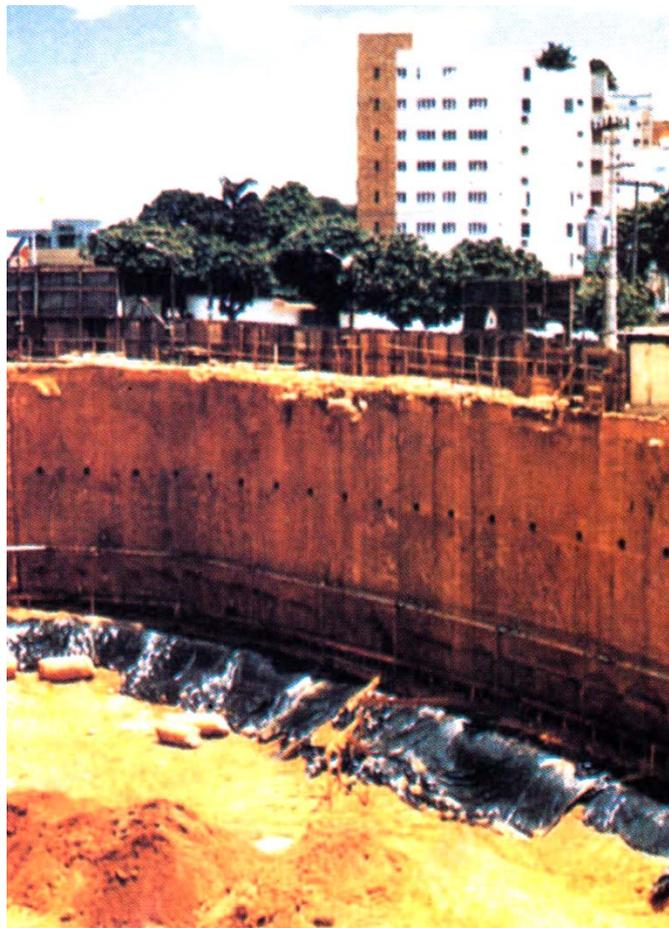
Figura 4.18 – Parede diafragma atirantada, em Goiânia (Fundesp, 2001).
