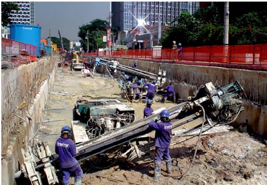
Figura 4.29 – Execução de tirantes sob passagem subterrânea (Brasfond, 2007a).
