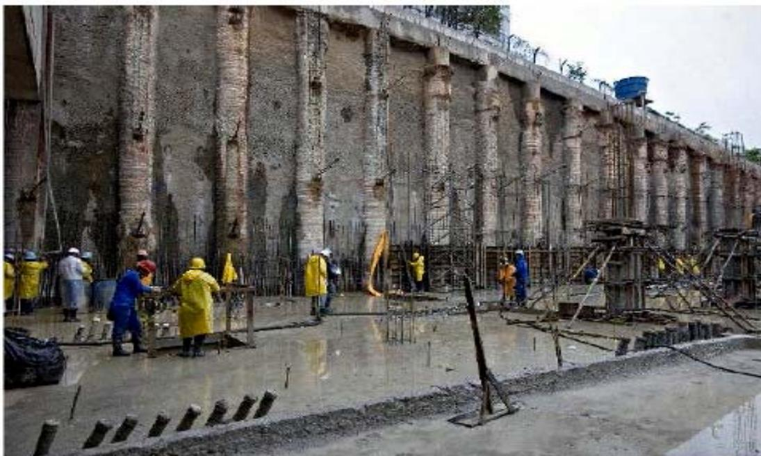
Figura 4.14 – Contenção com estacões de concreto atirantado (Peixoto & Carvalho, 2006).
