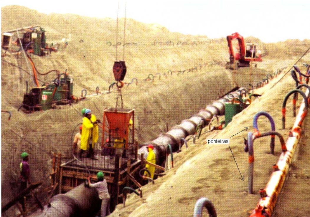
Figura 4.37 – Rebaixamento de lençol freático com ponteiras (modificado – Tecnogeo, 2005).
