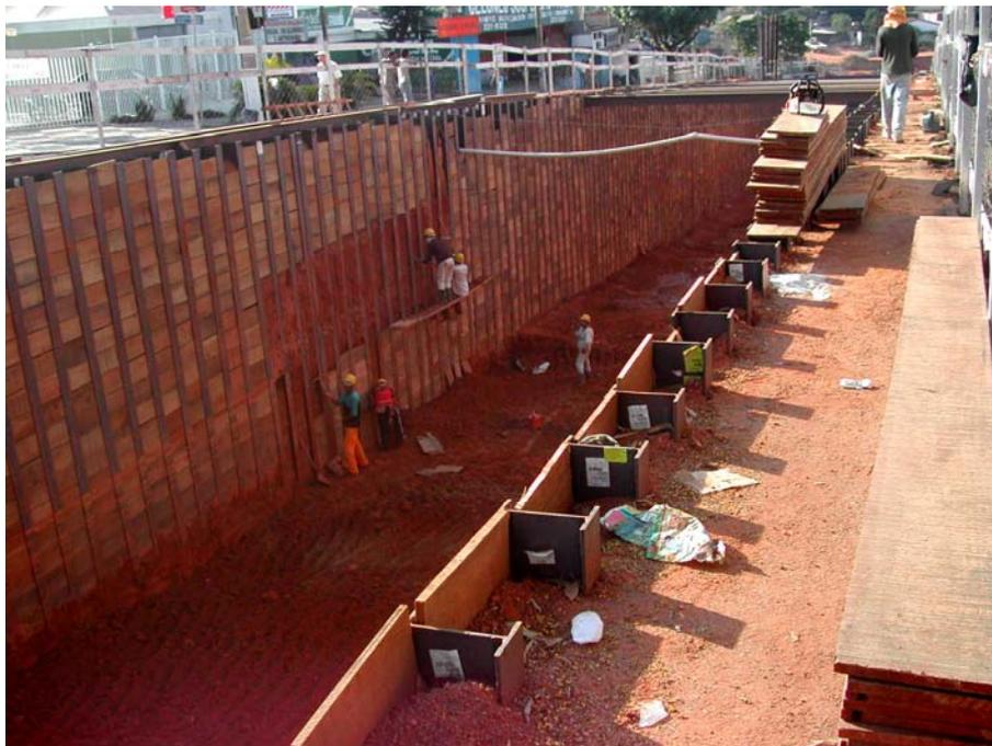
Figura 4.10 – Estacas metálicas com pranchões de madeira, em Goiânia (Mota, 2007).
