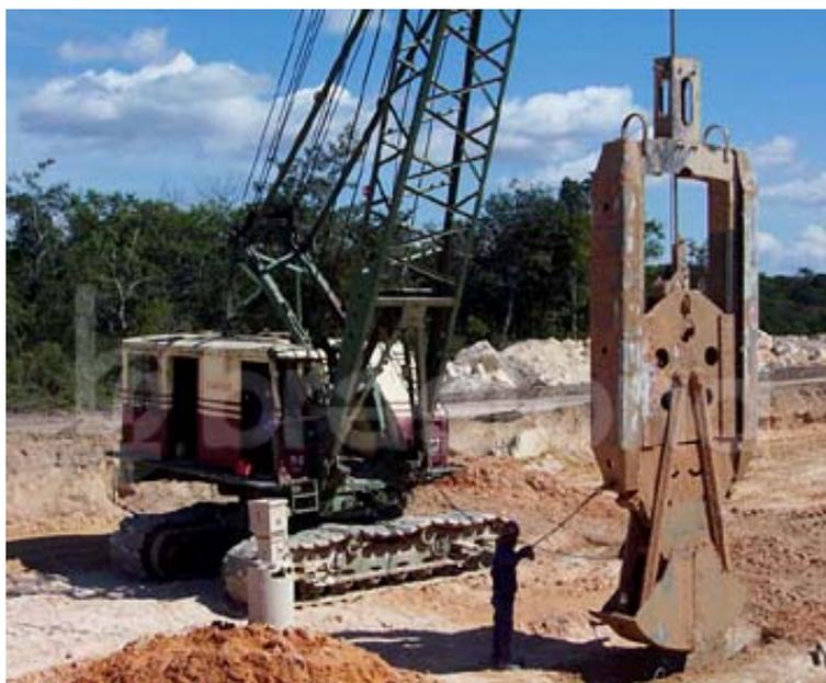
Figura 4.22 – *Clamshell* mecânico (Brasfond, 2007a).
