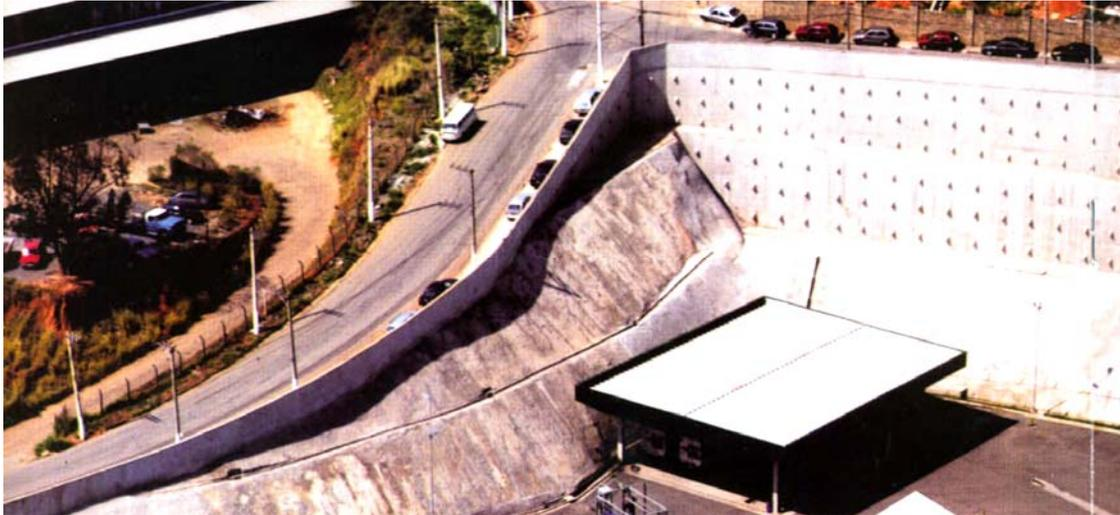
Figura 4.30 – Cortina atirantada para contenção de talude (Tecnogeo, 2005).
