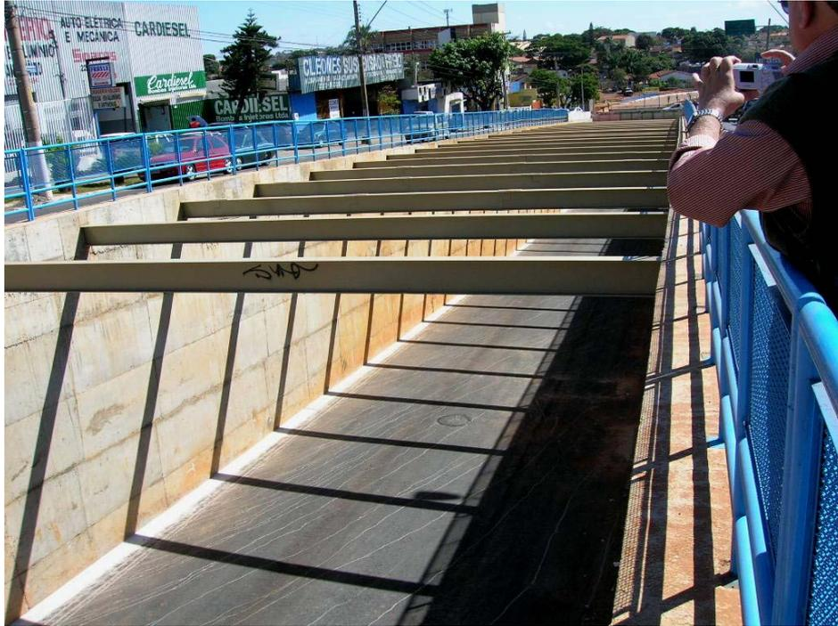
Figura 4.26 – Estrondas incorporadas à estrutura de contenção definitiva (Mota, 2007).
