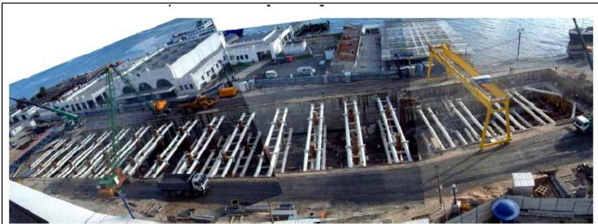
Figura 4.27 – Estrutura de contenção com estrondas (Peixoto & Carvalho, 2003).
