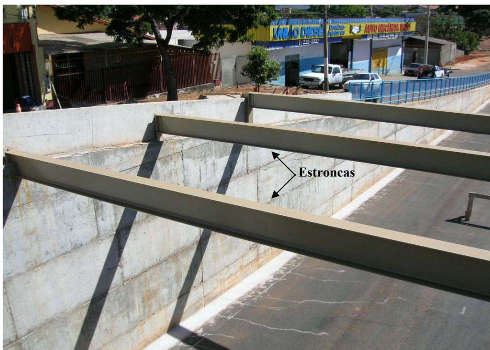
Figura 4.11 – Contenção definitiva com placas de concreto (modificado – Mota, 2007).
