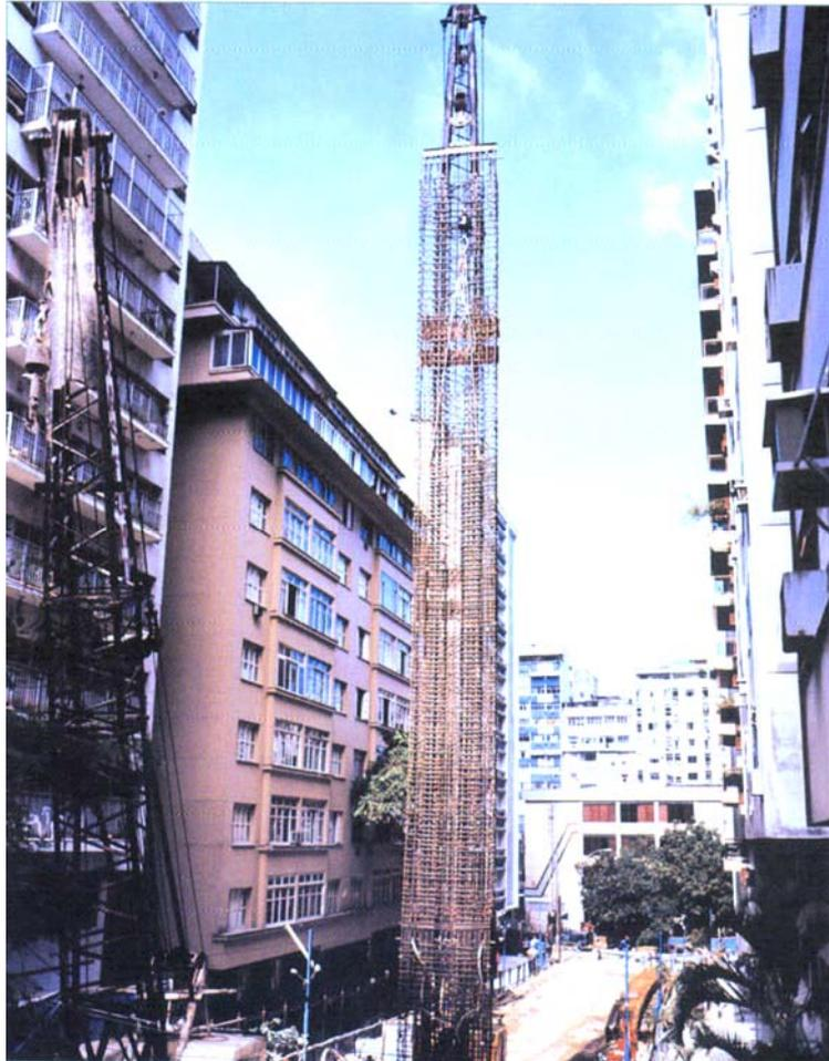
Figura 4.16 – Execução de parede diafragma no Metrô do Rio de Janeiro (Brasfond, 2007b).
