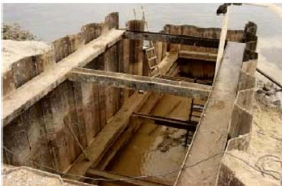
Figura 4.12 – Contenção com estacas-pranchas (Peixoto & Carvalho, 2006).
