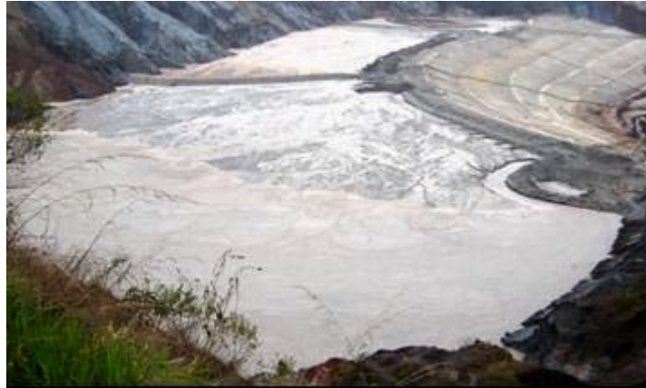
Figura 3.4: Barragem da Cava do Germano, da UIG / Samarco.
