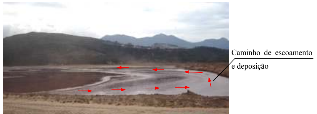
Figura 3.11: Geometria típica do processo de deposição da lama na BS3, da UIG / Samarco.
