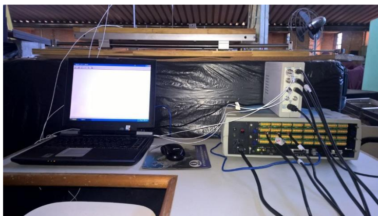
Figura 5.15 – Equipamentos utilizados para aquisição e processamento dos sinais derivados dos acelerômetros.
