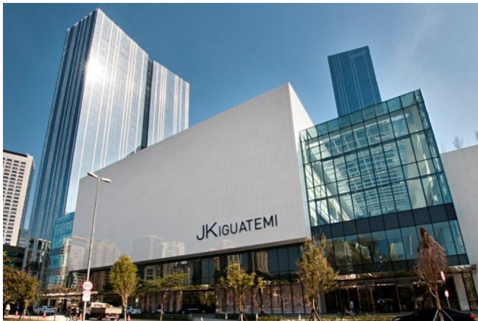
Figura 40 - Vista externa do empreendimento.
