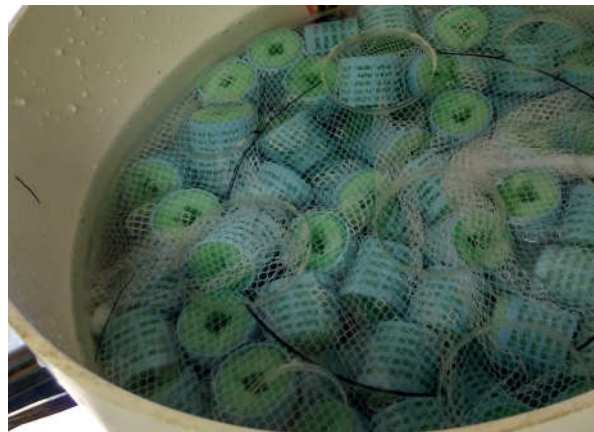
Figura 4.12: Vista superior do Filtro Anaeróbico em teste de operação
