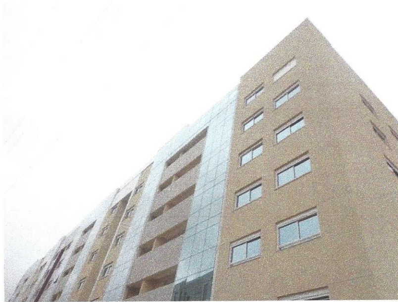
Figura A-0.5 – Foto Fachada – Fachada Sul (vistoria local ao prédio objeto de aplicação da metodologia)
