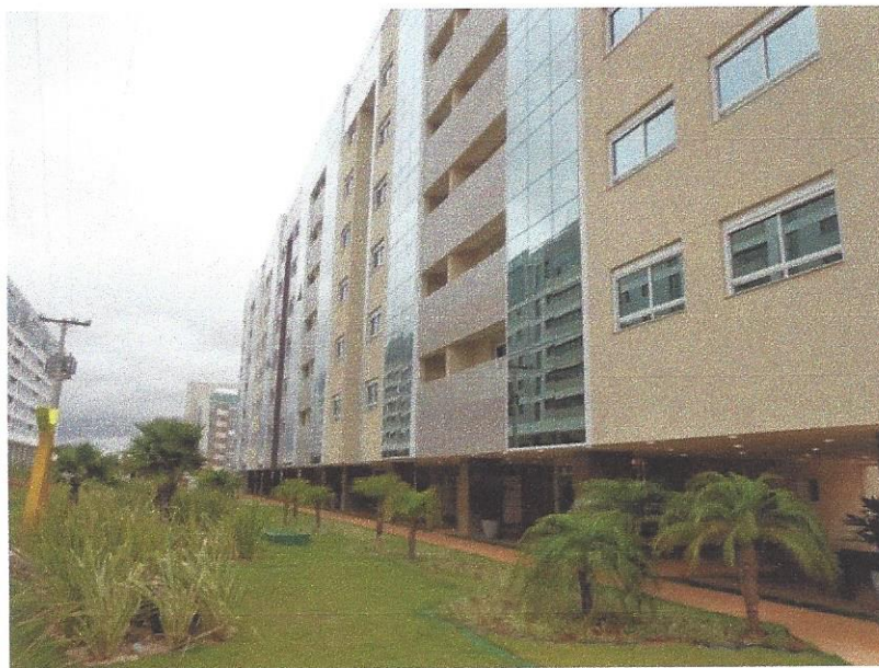
Figura A-0.6 – Foto Fachada – Fachada Sul (vistoria local ao prédio objeto de aplicação da metodologia)
