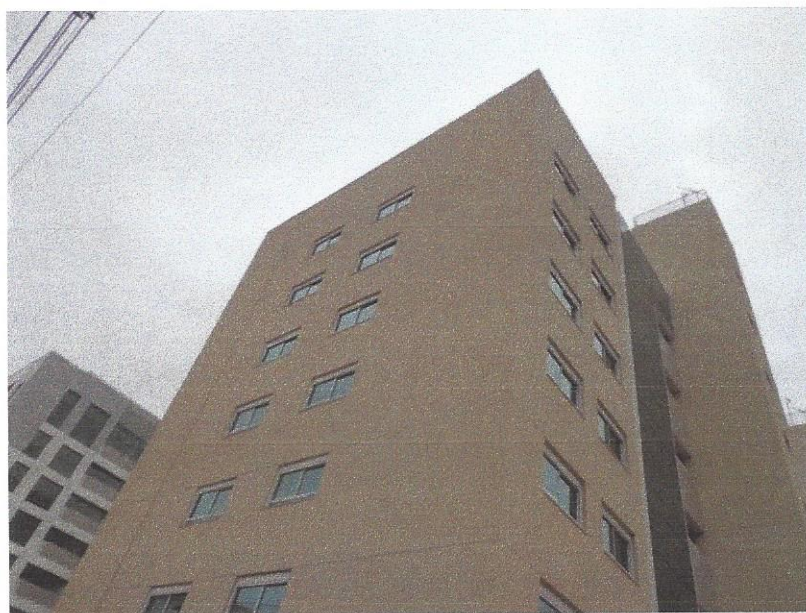
Figura A-0.3 – Foto Fachada – Empena Leste (vistoria local ao prédio objeto de aplicação da metodologia)
