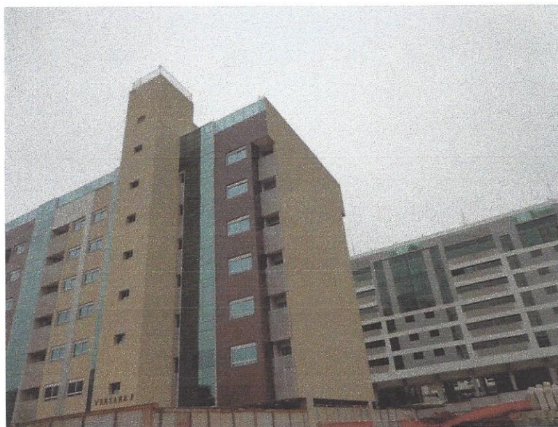
Figura A-0.9 – Foto Fachada – Empena Oeste (vistoria local ao prédio objeto de aplicação da metodologia)
