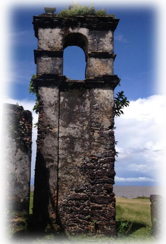
Figura 2 - Ruínas da Igreja de Nossa Senhora do Rosário em Joanes - Marajó Construída no período da missão jesuíta (1716), aparelhada com 3 altares: Nossa Senhora do Rosário, Jesus crucificado e Santo Antônio.
