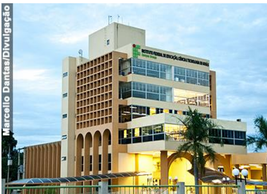
FIGURA 2 Prédio do Câmpus Uruaçu do Instituto Federal de Goiás
