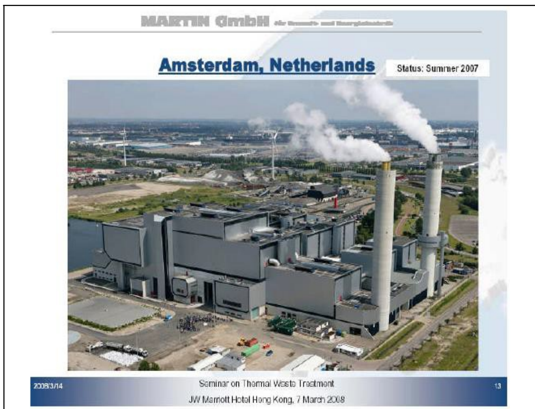
Figura 16 – Usina WTE de Amsterdam (4.500 ton/dia). Fonte: Ribeiro (2010)
