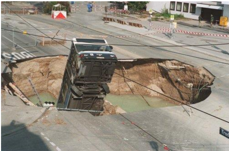
Figura 2.9 – Ônibus urbano dentro da abertura produzida pelo colapso. Munique, Alemanha 1994 (Seidenfuss, 2006).
