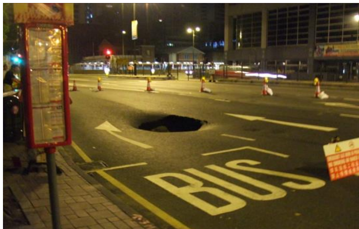
Figura 2.14 – Colapso numa seção entre as estações de Jordânia e Rodoviária Tsui East Tsim Sha , Hong Kong (G.E.O, 2012).
