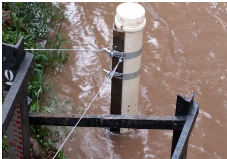
Figura 26 – Instalação da sonda multiparamétrica em 90° dentro do corpo hídrico
