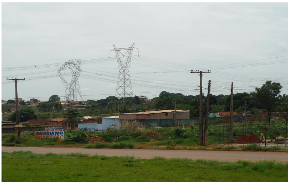
Figura 5.6 – Visada diagonal do perímetro urbano do município de Águas Lindas de Goiás (Entorno do Distrito Federal) com situações de vazio urbano criado pelas faixas de servidão das Linhas de Transmissão 500 kV Norte-Sul, Circuitos 1, 2 e 3. Data: Novembro/2015.
