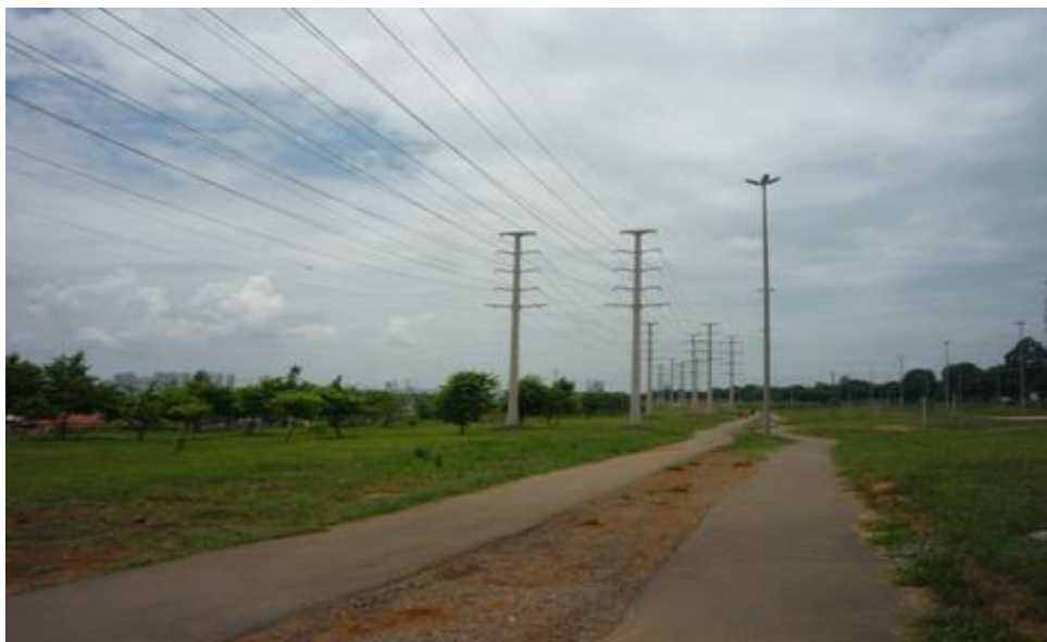
Figura 5.10 – Extinção de um vazio urbano com a construção de um parque urbano com ciclovia – Vista da Linha de Transmissão 138 kV Taguatinga-Taguatinga Norte e da Linha de Transmissão 138 kV Taguatinga-Ceilândia, parque urbano Taguaparque, Taguatinga, Distrito Federal. Data: Novembro/2015.
