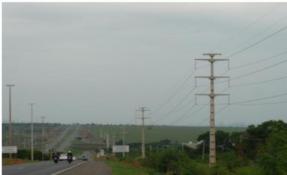
Figura 5.8 – Situação de sinergia entre faixa de domínio da Rodovia BR - 060 e a faixa de servidão da Linha de Transmissão 138 kV Samambaia-Monjolo (sentido Brasília-Goiânia). Data: Novembro/2015.
