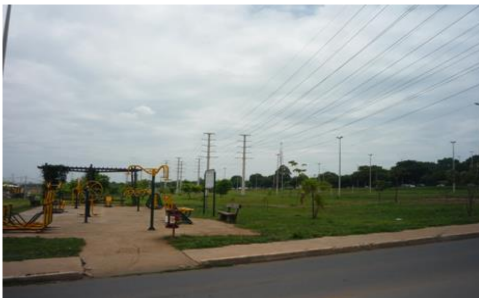
Figura 5.9 – Extinção de um vazio urbano com a construção de um parque urbano e vivencial – Vista da Linha de Transmissão 138 kV Taguatinga-Ceilândia e da Linha de Transmissão 138 kV Taguatinga-Taguatinga Norte, parque urbano Taguaparque, Taguatinga, Distrito Federal. Data: Novembro/2015.
