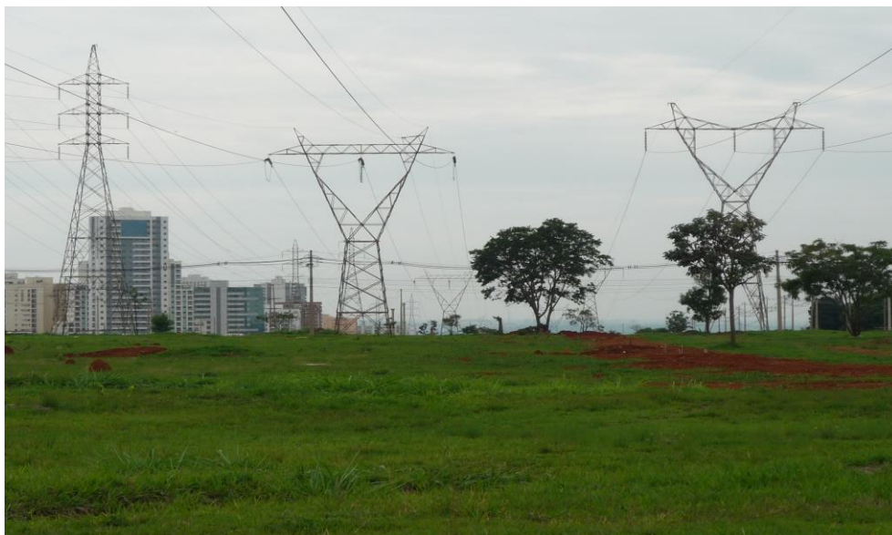
Figura 5.7 – Vazio urbano em Taguatinga Sul (Distrito Federal) – Vista da direita para esquerda: faixas de servidão das Linhas de Transmissão 230 kV Brasília Sul-Brasília Geral, circuitos 1 e 2, e da faixa de servidão da Linha de Transmissão 138 kV Brasília Sul-Brasília Norte 51 . Data: Novembro/2015.
