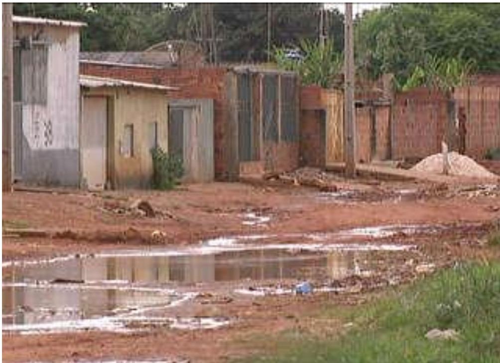
Figura 29 - Falta de esgoto, asfalto e segurança.
