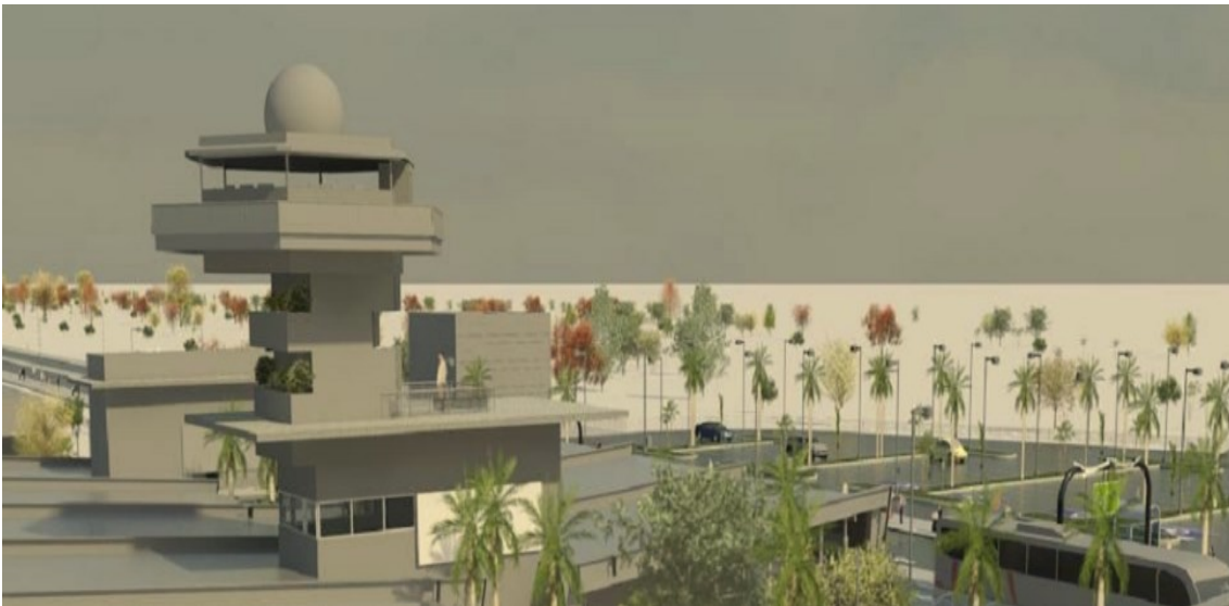
Figura 67- Vista do Terminal de Passageiros Regional modificado – TWR2.
