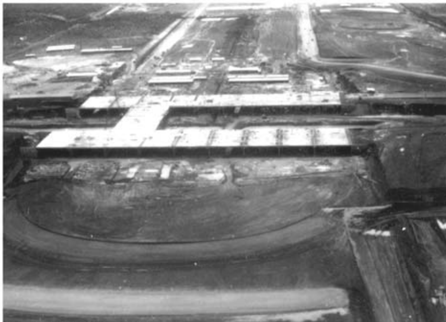
ARQUIVO PÚBLICO DO DF NOV.D.04.04.B.16 Nº 1621 CONTEÚDO: CONSTRUÇÃO DA ESTAÇÃO RODOVIÁRIA LOCAL: BRASÍLIA-DF - DATA: [1957-1960] AUTOR: NÃO IDENTIFICADO
