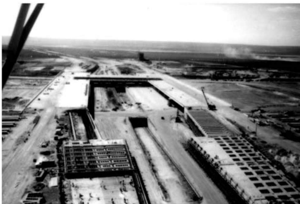
ARQUIVO PÚBLICO DO DF NOV.D.04.04.B.16 Nº 1622 CONTEÚDO: CONSTRUÇÃO DA ESTAÇÃO RODOVIÁRIA LOCAL: BRASÍLIA-DF - DATA: [1957-1960] AUTOR: NÃO IDENTIFICADO
