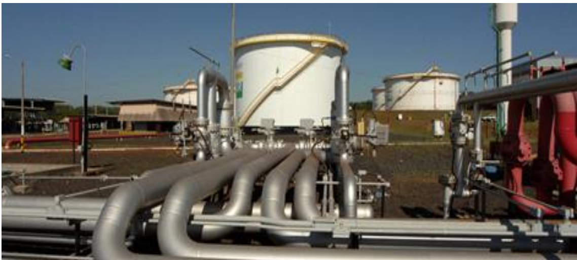
Figura 1.3 – Terminal Ribeirão Preto – São Paulo, Brasil (Fonte: Obtida em site {3}).
