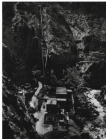
Figura 2.5 – Deslocamento horizontal do duto. Usina Hidrelétrica de Arequipa, Peru (Fonte: Chaudhry, 1988).
