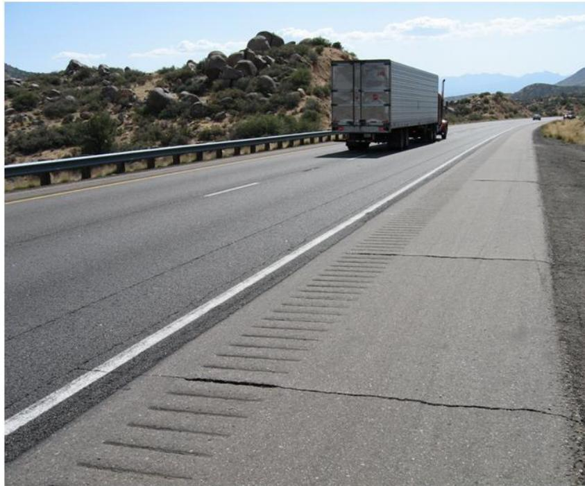
Figura 4.30 – Trincas de retração na camada asfáltica convencional (acostamento) e faixas de rolamento sem reflexão das mesmas (mistura aberta) – Projeto *Silver Springs*.
