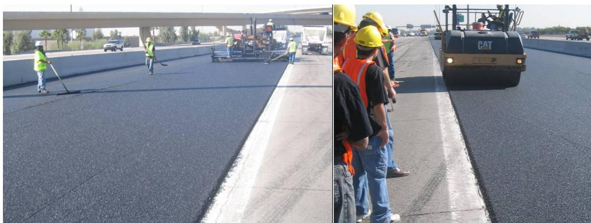
Figura 3.1 – Aplicação de uma camada de revestimento asfáltico aberto sobre um pavimento rígido.
