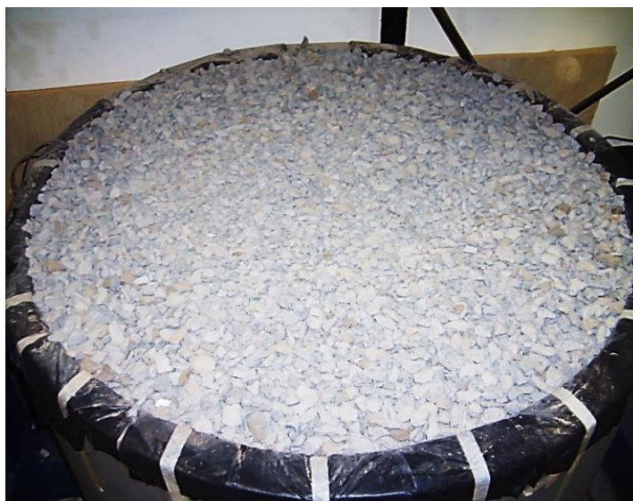
Figura 3.21 Colocação da camada de aterro.
