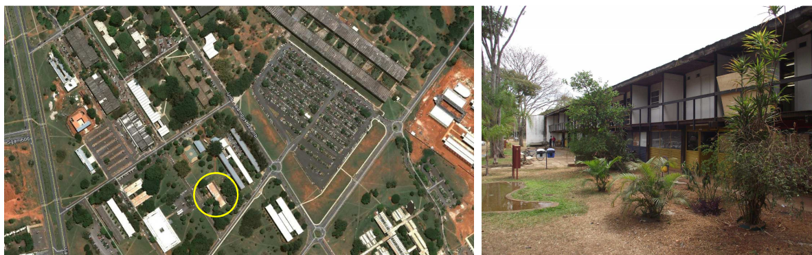
Figura 1: Campus Universitário Darcy Ribeiro – UnB, Brasília/DF, Pavilhão OCA-2 dentro do círculo amarelo. Fonte: Google Earth. Figura 2 – Fachada Oeste (frontal) – OCA-2 Foto: Oscar L. Ferreira.
