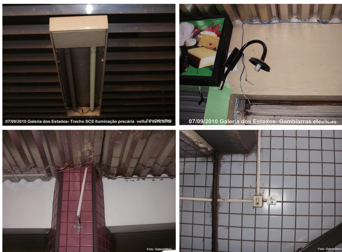
Figura 24 - Situação das instalações elétricas na Galeria dos Estados
