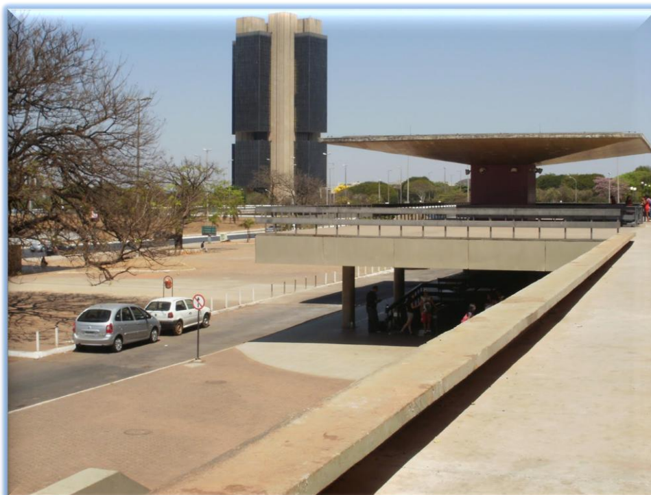
Figura 6 - Plataforma Superior da Galeria dos Estados, no Setor Comercial Sul (SCS), às 9h de uma manhã de domingo. Acesso à Estação Metroviária Galeria, ao Setor Bancário Sul (SBS) e ao Setor de Autarquias Sul (SAS). Escadarias no SBS permitem acesso direto ao Complexo Cultural da República (Biblioteca Nacional e Museu Nacional), bem como à Esplanada dos Ministérios. Ao fundo, vista do Banco Central do Brasil. Foto: Gabriel Melo.
