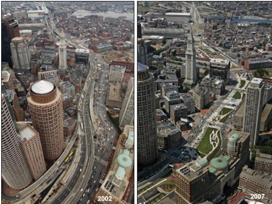
Figura 263 - Boston: Fitzgerald Expressway (antes e depois). Em 2002 – av. expressa antes de finalizar o projeto BigDig. Em 2007 – área revitalizada após a finalização do projeto BigDig.
