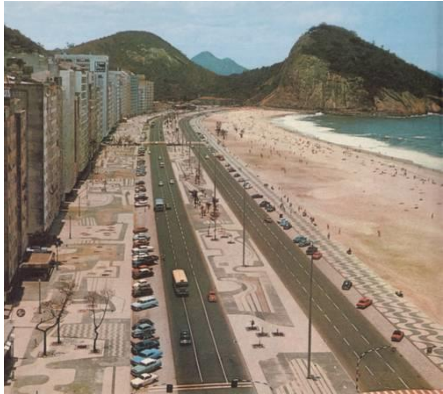
Figura 279 - Rio de Janeiro: Av. Atlântica na gestão Negrão de Lima (1969 e 1971). Realização de aterro e duplicação da avenida.
