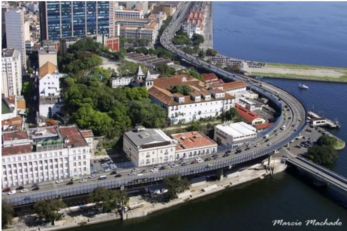
Figura 270 - Rio de Janeiro: Elevado da Perimetral.
