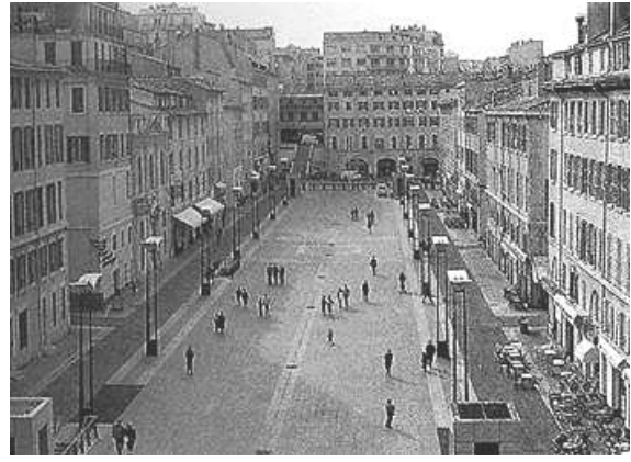
Figura 258 - Marselha (1989). Requalificação da área, após a demolição do estacionamento. Fonte: RAMONEDA, 1999.
