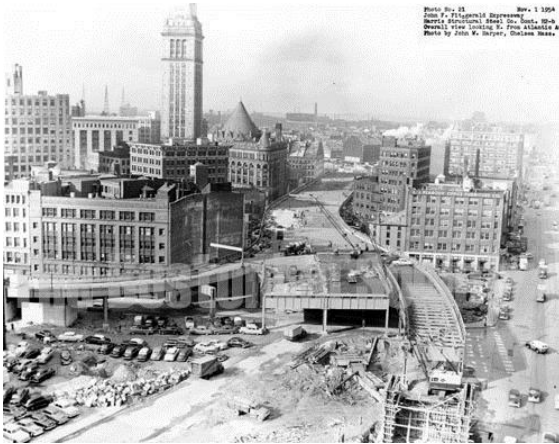
Figura 253 - Boston: construção da Fitzgerald Expressway (1954).
