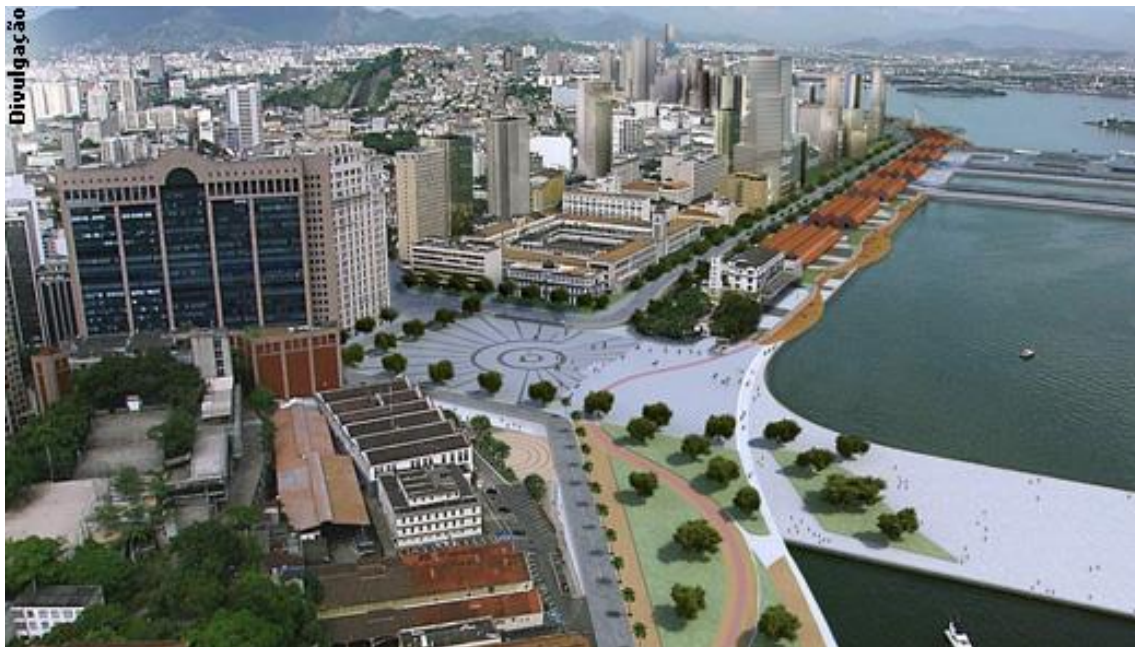
Figura 271 - Rio de Janeiro: Elevado da Perimetral após a demolição.
