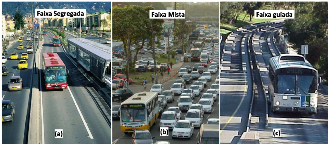
Figura 3.1 Tipos de vias para corredores BRT. Fonte: adaptada de Wright (2008).
