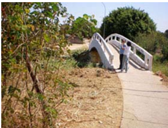
Fig. 6.16. Ponte Boca Louca – P3; vista a partir da Vila Metropolitana.
