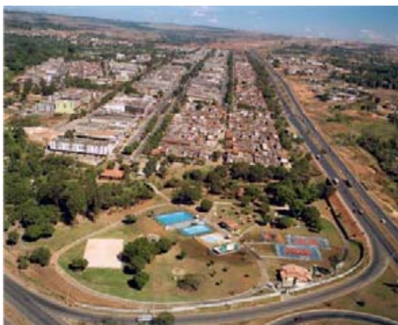
Fig. 6.10. Foto aérea do Núcleo Bandeirante; em primeiro plano, o clube do SESI; a ponte de pedestres interna à área passa sobre o Córrego Vicente Pires.
