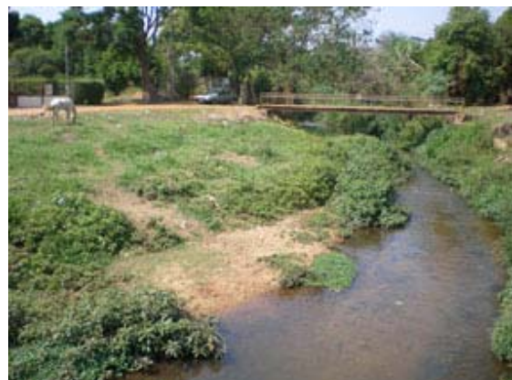
Fig. 6.17. Ponte de pedestres na área 2 – P6, atrás do Fórum, ligando à Vila Cauhy.
