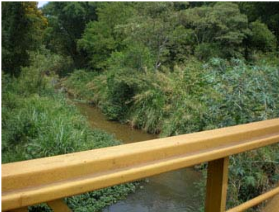
Fig. 6.42. Ponte P2: parapeito vazado permite o acesso visual ao Riacho Fundo.
