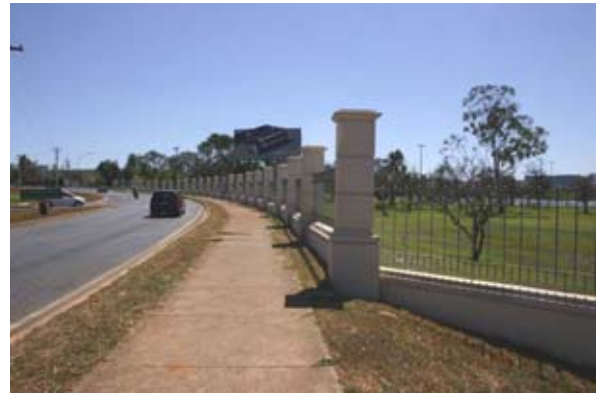
Fig.5.30. Pontão Sul, Projeto Orla, Brasília; grade contornando a área.
