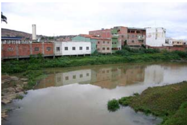
Fig. 5.25. Salinas; fundos de edificações voltados para o corpo d'água.
