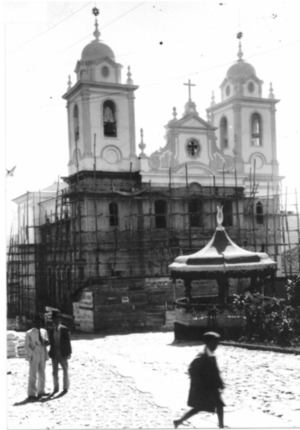
Fig. 43 – Catedral em construção e Coreto recolocado/1937 Fonte – Acervo Foto Assis
