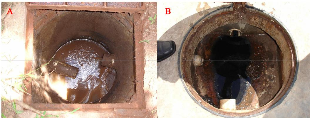
Figura 14 – Fotos de caixas de inspeção exemplificando problemas referentes ao de excesso de resíduos sólidos (A) e óleo (B).
