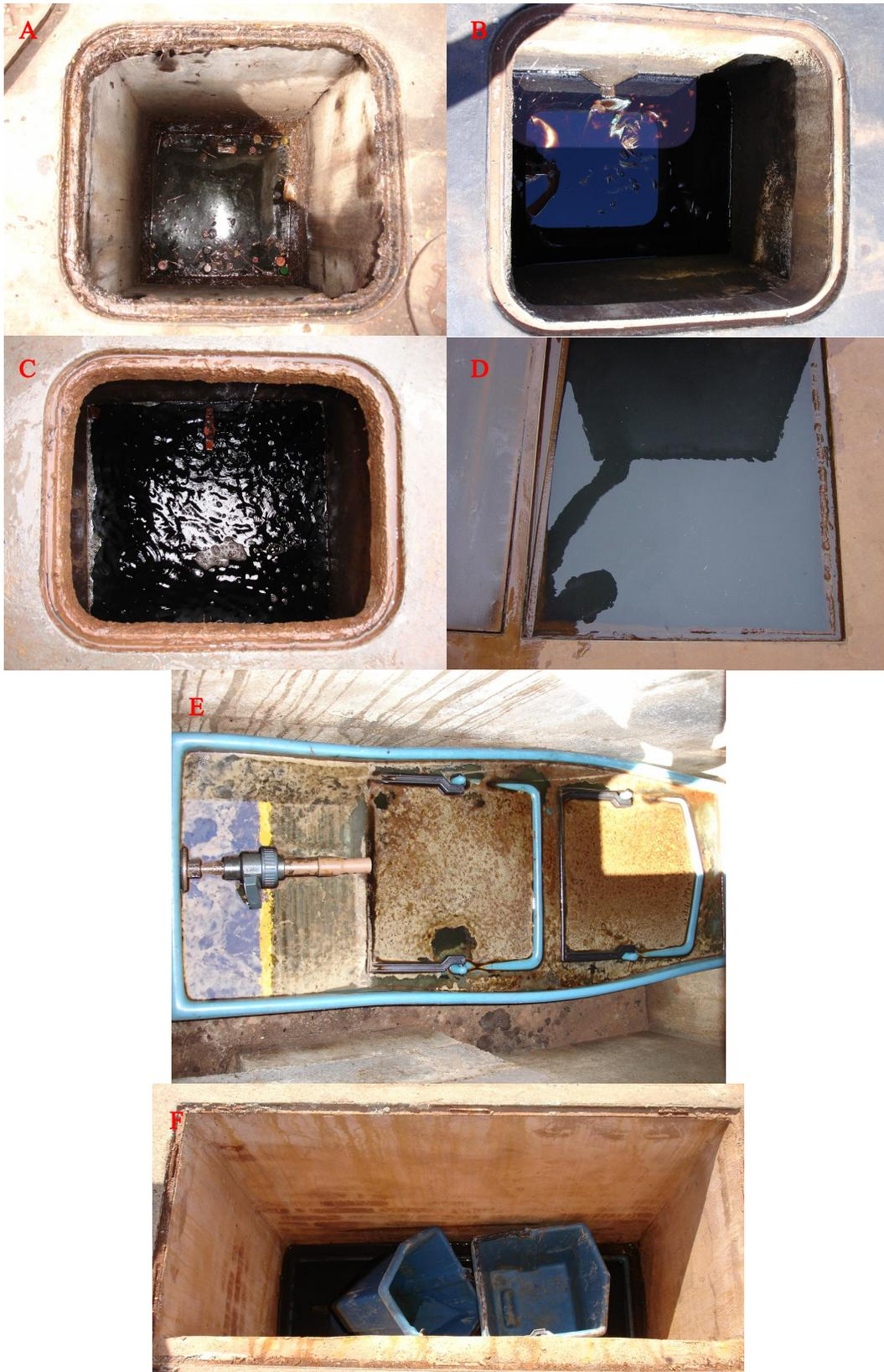
Figura 16 – Fotos de caixas coletoras de óleo exemplificando problemas referentes à falta de registro (A-B) e ao acúmulo de efluente (C-F).
