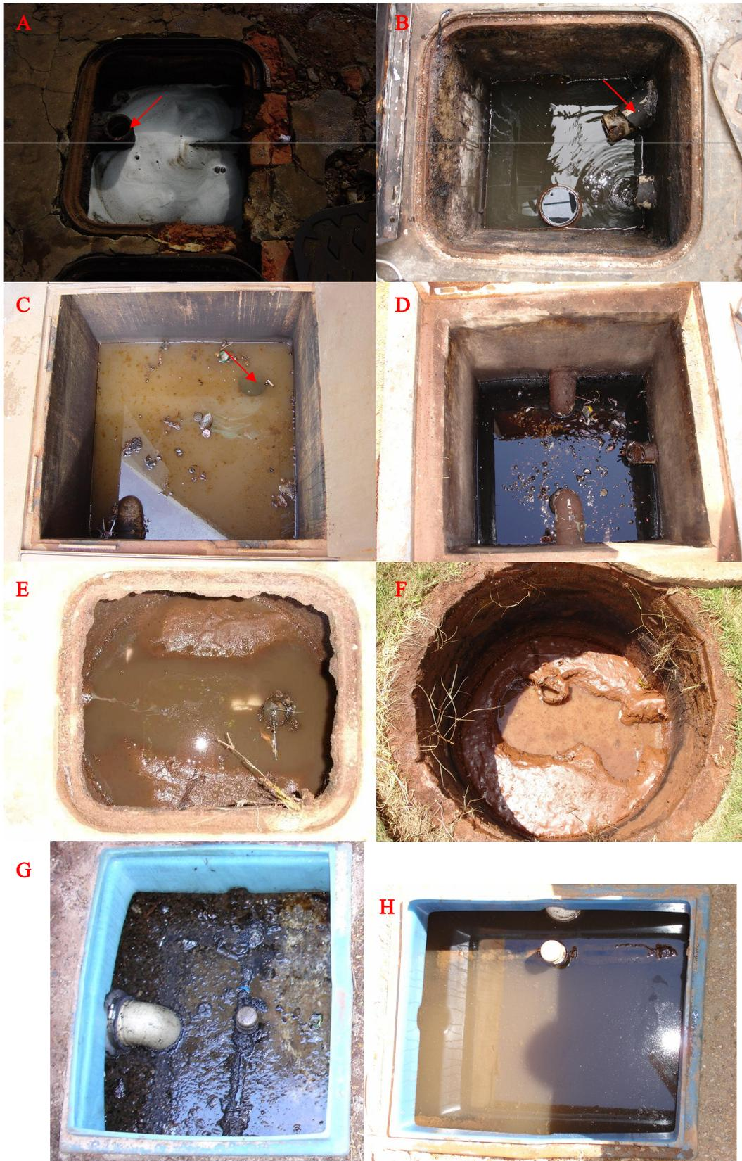
Figura 15 – Fotos de caixas separadoras exemplificando problemas referentes ao posicionamento inadequado da saída do óleo (A), arquitetura inadequada do tubo condutor para caixa de inspeção/esgoto (B), saída do óleo encoberta por efluente (C) e acúmulo de resíduo sólido (D-G) e efluente (H).
