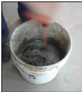
Figura 4.9 Mistura da argamassa
