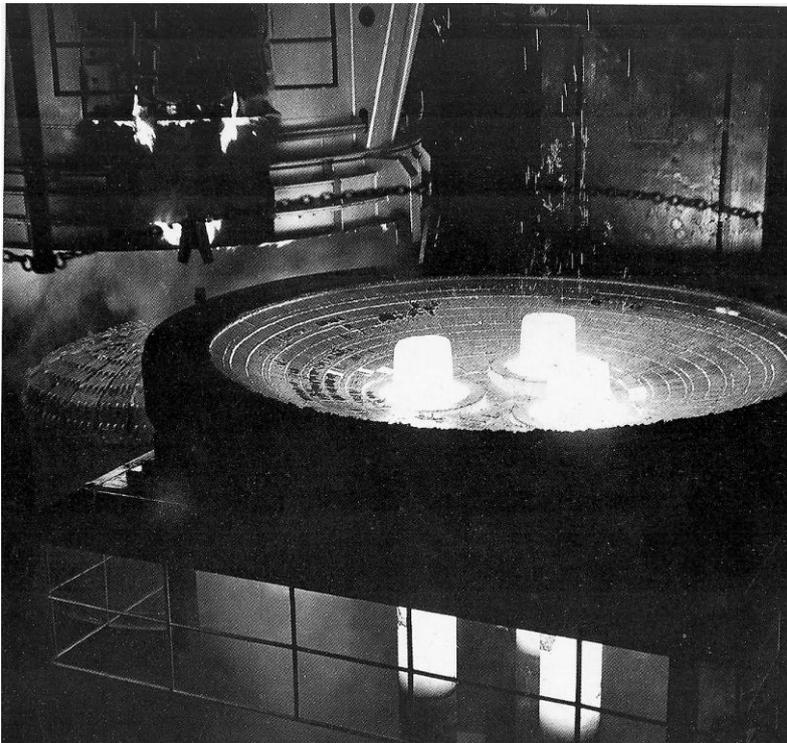
**Foto:** Forno elétrico de redução. Ano: 1972. Fonte: Escritório Central da Acesita.
