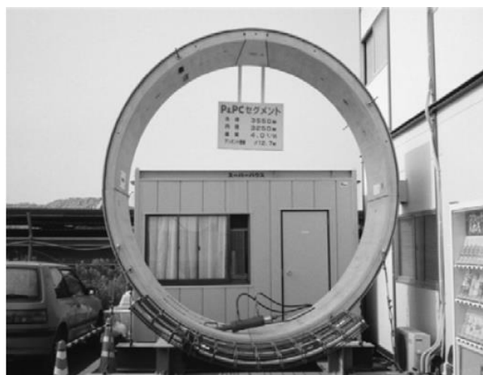
Figura 4.4. Segmento de concreto protendido (Nishikawa, 2003).
