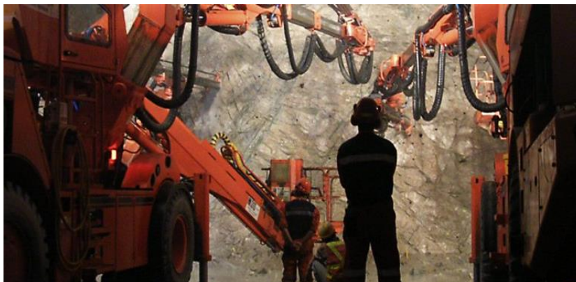
Figura 2.4. Máquinas jumbo aplicando explosivos em uma frente de escavação (Lander, 2012).
