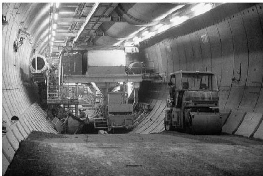
Figura 4.3. Segmentos em concreto pré-moldado instalados por tuneladora (Herrenknecht et al. , 2008).
