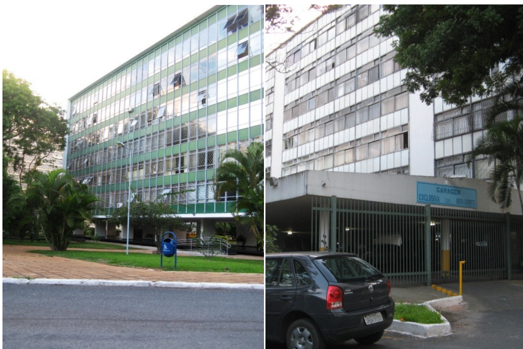
Figura 23 e 24 – Foto da obediência da estrutura dos blocos residenciais, e da invasão do espaço público para fins próprios (estacionamento particular), respectivamente.
