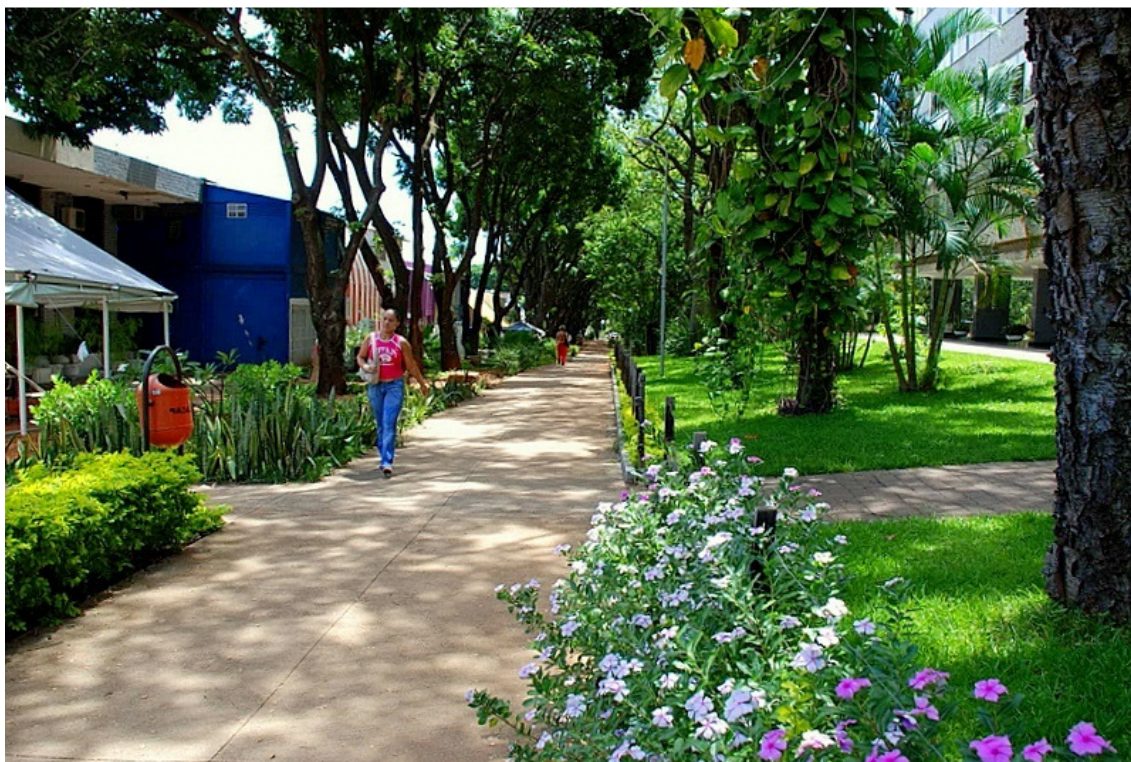
Figura 21 – Foto das calçadas acessíveis, no entanto sem piso tátil para portadores de necessidades visuais.
