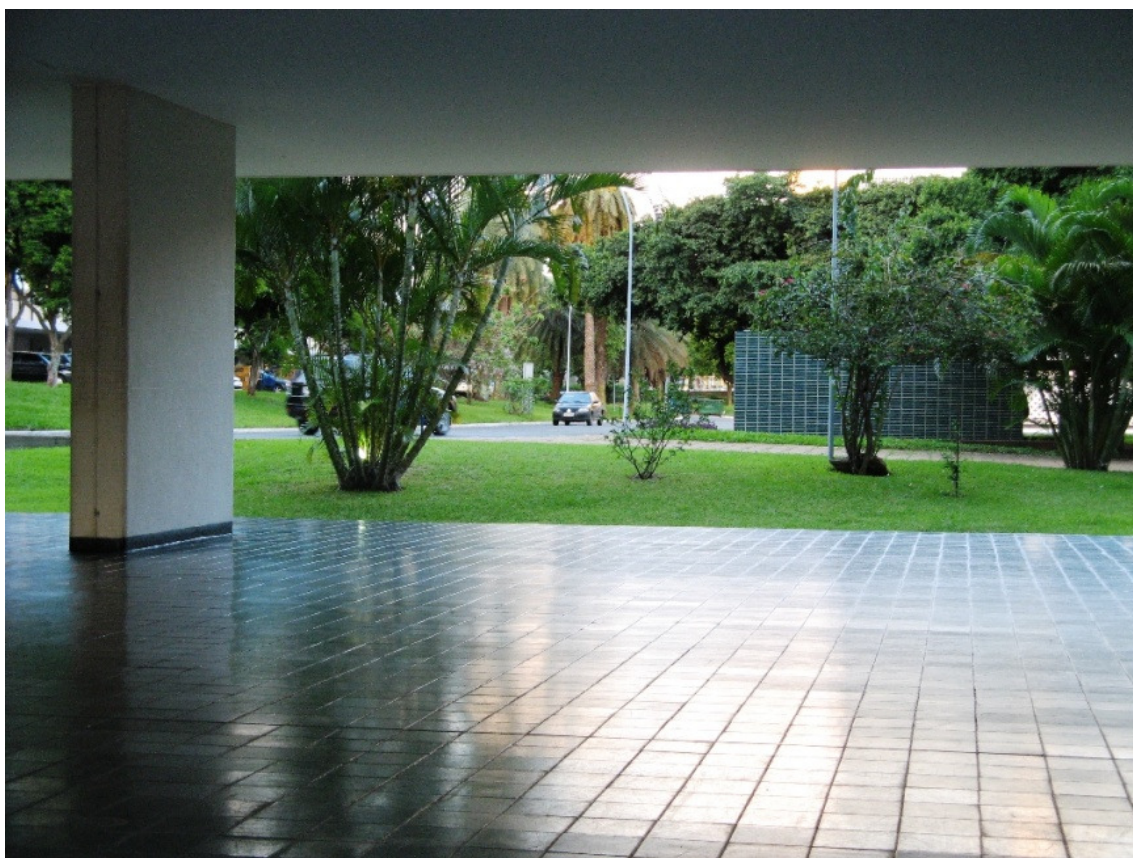
Figura 20 – Foto da permeabilidade dos pilotis possibilitando a diversidade de rotas.
