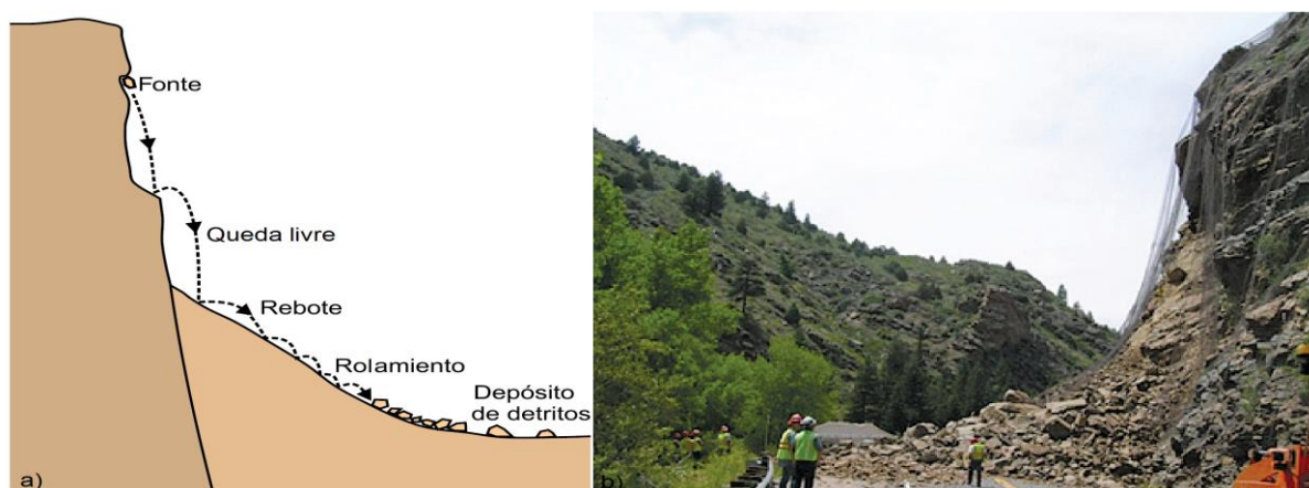
Figura 3.1. Quedas. a) Esquema da queda de rochas (PMA: GCA, 2007). b) Queda de rochas em Clear Creek Canyon, Colorado, USA ((Highland & Bobrowsky, 2008).
