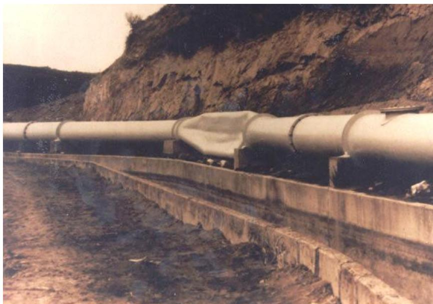
Figura 1.1: Colapso em trecho de adutora de abastecimento de água. *Fonte: Haper International (2009).*
