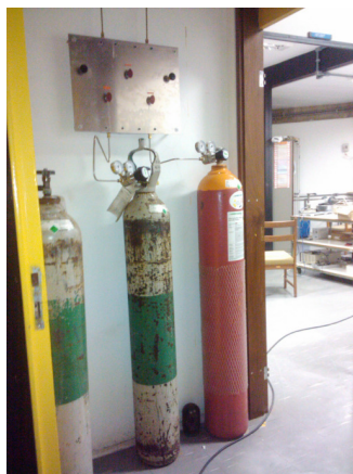
Figura 3.47 – Central de gás para alimentação do TCFB, com a montagem para utilização com dois gases diferentes.
