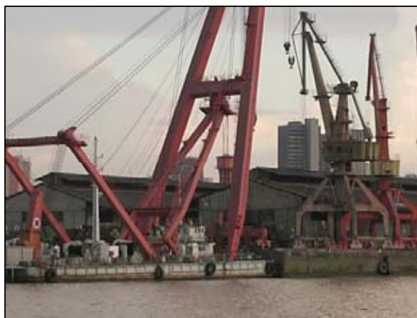
Figura 6.15 - Utilização de cábrea flutuante no carregamento e descarregamento de carga
